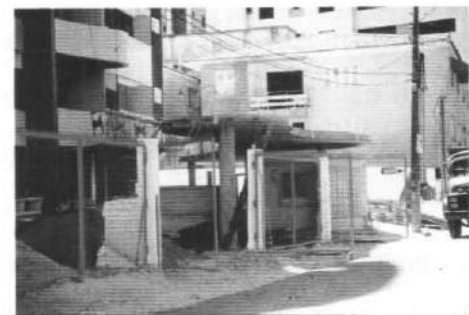
Foto 5.4 – Marquise com laje protendida (Foto: Gerardo Santos Filho)
