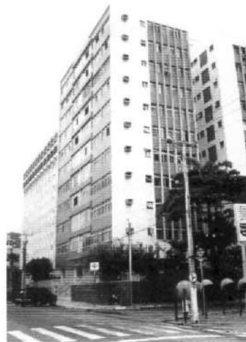
Foto 7.65 - Edifício Arpoador, Av. Beira Mar
