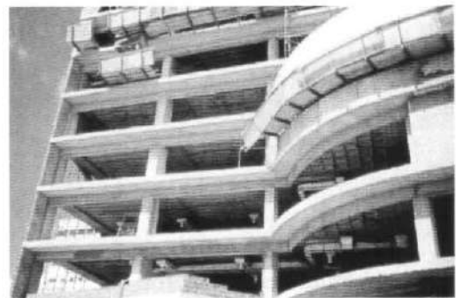
Fig. 7.7 – Estrutura (Fonte- Revista AU)
