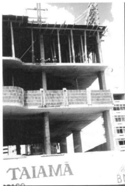
Foto 7.80 - Edifício com laje protendida maciça
