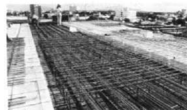
Fig. 7.11 - Protensão / laje (Fonte - Revista AU)
