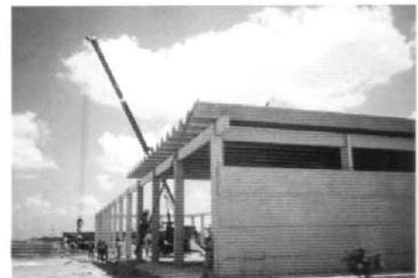
Foto 7.56 – Galpão / Fábrica T&A
