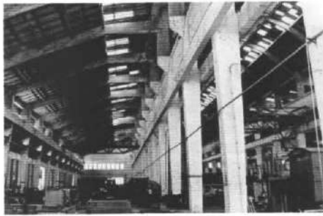
Foto 7.9 – Detalhe estrutura / galpão (Foto: Adriana Bardawil)
