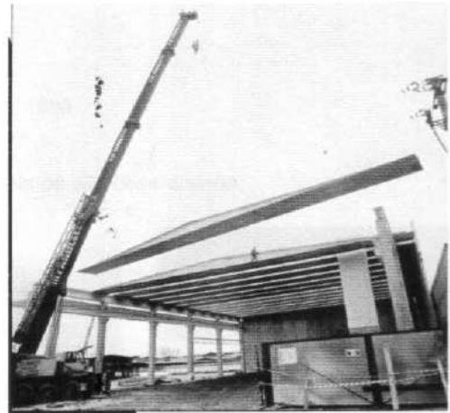
Fig. 7.16 – Montagem / Galpão Concretópolis (Fonte - Concretópolis)
