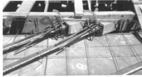
Fig. 5.5 - Ancoragem ativa (Fonte: Revista AU)
