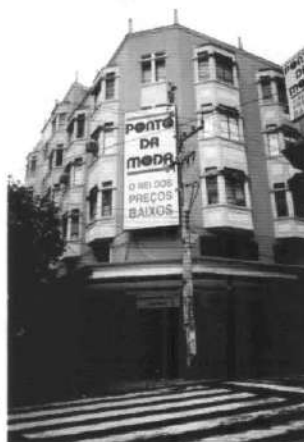
Foto 7.16 - Edifício Parente proj. Sylvio Jaguaribe Ekman
