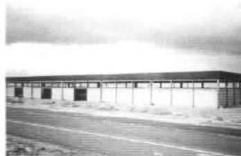
Foto 7.61 - Galpão Porto do Pecém (Foto: Dácio Carvalho)
