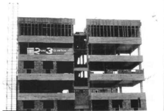
Foto 7.75 - Edifício de apartamentos com esquema estrutural convencional
