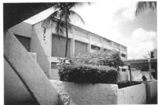
Foto 7.41 - Bloco / salas de aula
