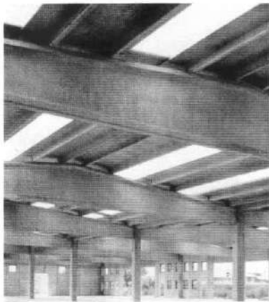
Fig. 7.15 – Galpão Concretópolis / Fortaleza (Fonte - Concretópolis)
