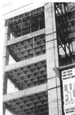
Foto 7.76 – Aspecto / laje nervurada
