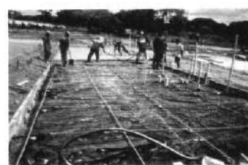
Fig. 7.14 - Execução da protensão (Fonte - Revista Techne)
