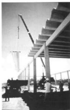
Foto 7.57 - Montagem telha / galpão T&A
