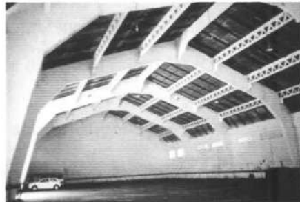
Foto 7.32 - Galpão anexo ao Tribunal
