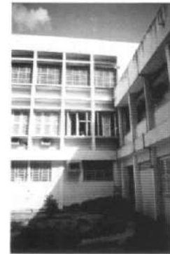
Foto 7.36 - Bloco Anexo Reitoria / UFC
