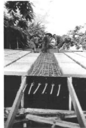
Fotos 5.1 e 5.2 – Execução da protensão de uma laje (Foto: Gerardo Santos Filho)
