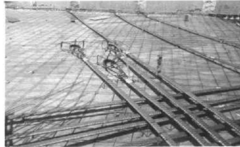
Fig. 5.6 - Ancoragem passiva (Fonte: Revista AU)
