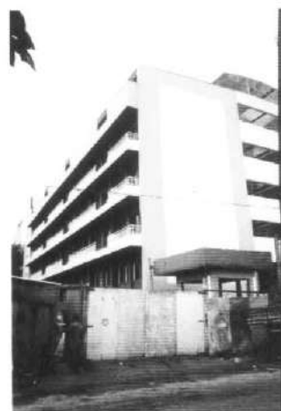
Foto 7.64 - Prédio FIC, rua Oswaldo Cruz Estrutura e vedações executadas com pré-moldados
