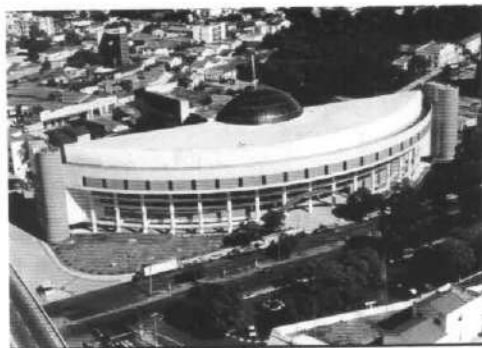
Foto 7.86 - Vista externa (fonte: construtora Marquise)
