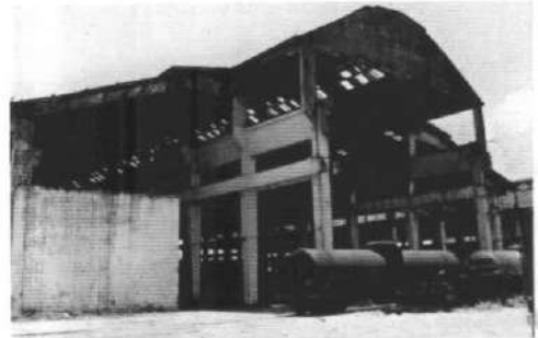
Foto 7.10 – Exterior / galpão (Foto: Adriana Bardawil)
