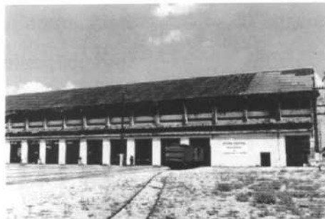
Foto 7.11 - Galpão (Foto: Adriana Bardawil)
