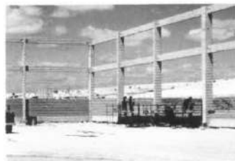
Foto 7.60 – Estrutura / Galpão Porto do Pecém (Foto: Dácio Carvalho)
