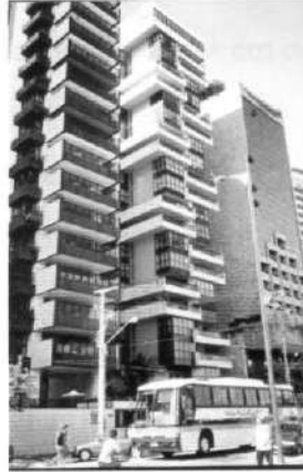
Foto 7.78 - Edifício Juan Miró, av. Beira Mar
