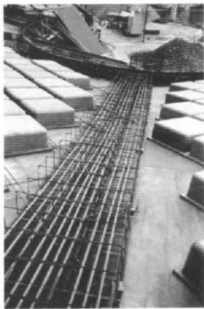
Fotos 5.1 e 5.2 – Execução da protensão de uma laje (Foto: Gerardo Santos Filho)
