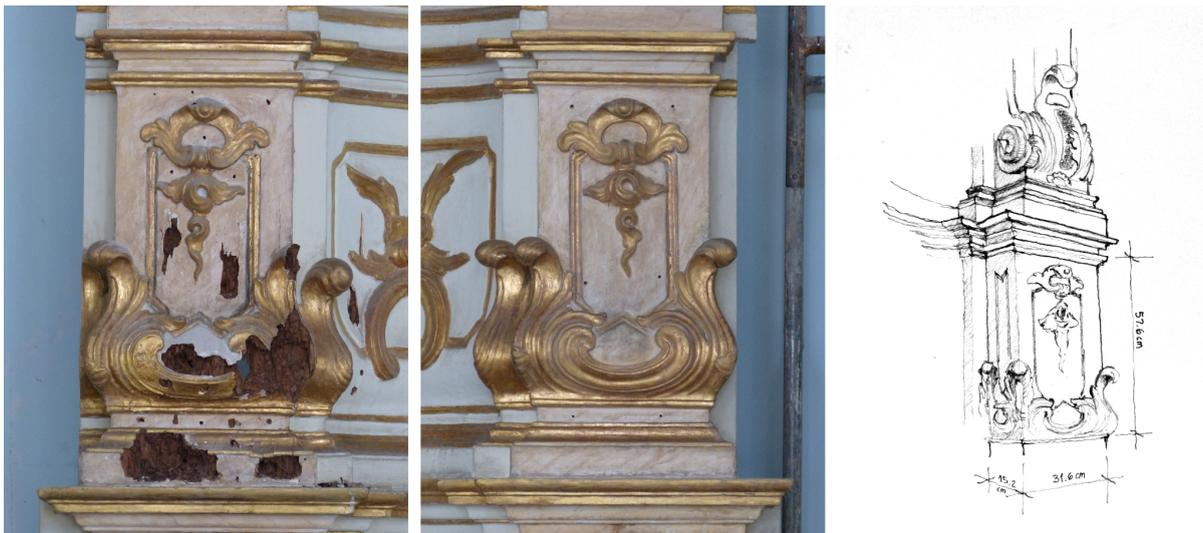
**Figura 25:** À esquerda, a base da coluna do evangelho. Ao centro, a base da coluna das epístolas. À direita, um croqui realizado a partir de observação da base da coluna das epístolas, explicitando suas dimensões. (NOGUEIRA et al. 2019).
