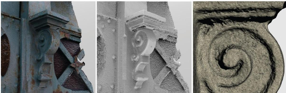
**Figura 15:** Resultado de reconstrução fotogramétrica de ornamento no Mercado do Pinhões utilizando o software Agisoft PhotoScan. Fonte: Moreira et al. (2016, p.192).
