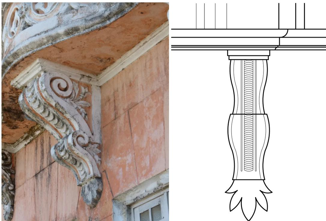
**Figura 1:** À esquerda, ornamento presente na fachada da Antiga Residência do Engenheiro-Mor da Ferrovia, em Fortaleza-CE. À direita, trecho do levantamento realizado pelo IPHAN que mostra a documentação produzida para tal elemento (Acervo LED-UFC).
