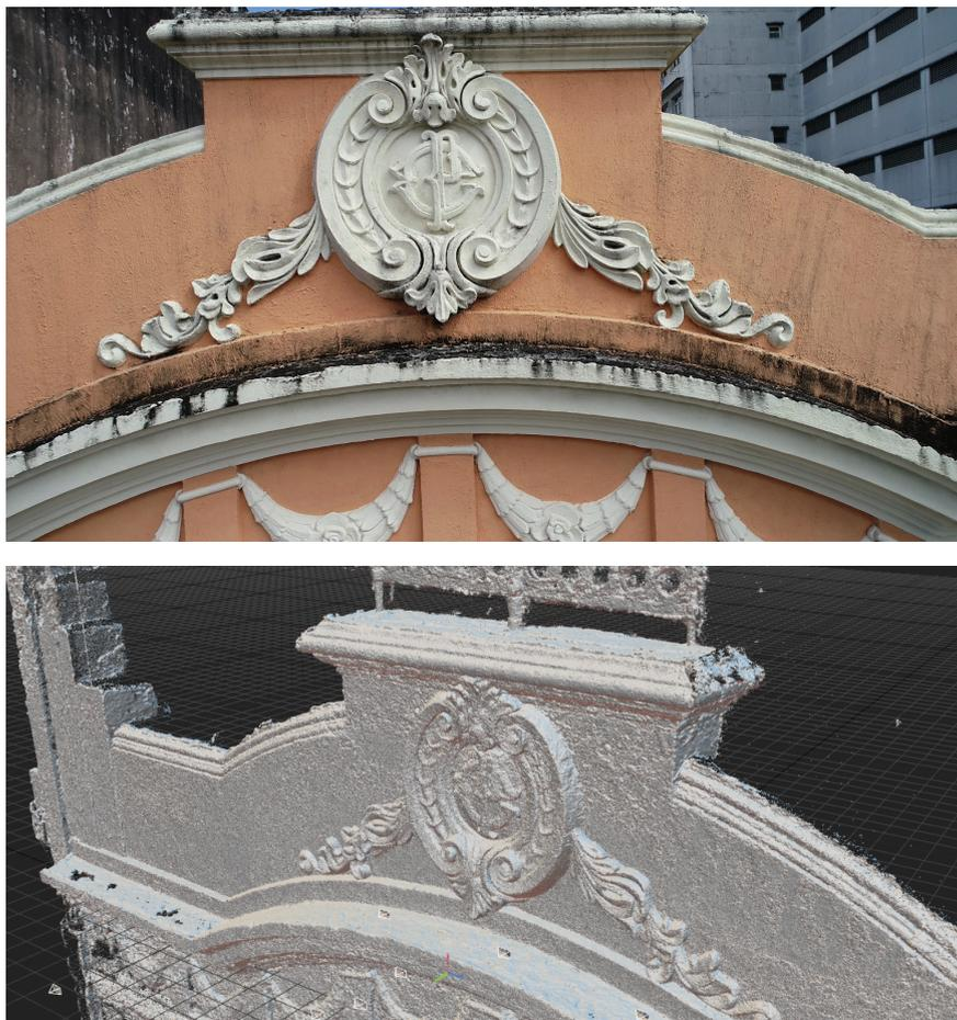
**Figura 38:** foto do ornamento capturado na fachada da farmácia (superior) e modelo reconstruído no software Reality Capture.
