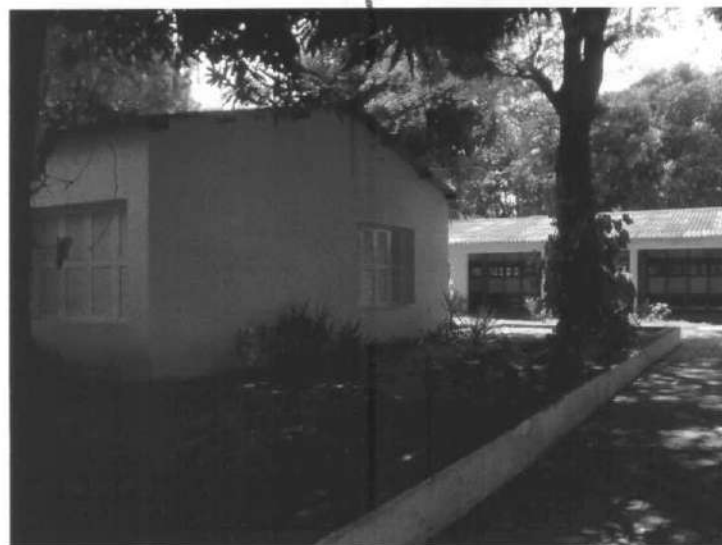
Figura 33– Vista Externa de uma Sala de Aula do DAU. Fonte: Foto do autor
