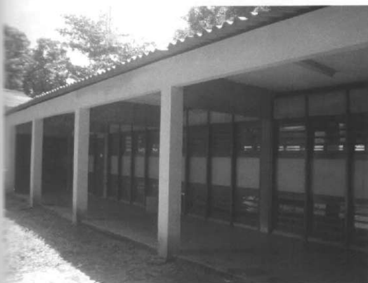
Figura 34 – Vista Externa das Salas de Aulas do DAU. Fonte: Foto do autor
