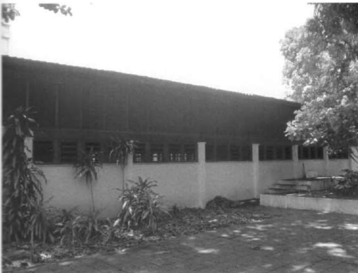
Figura 31 – Vista Lateral 2 do Pavilhão Martins Filho do DAU. Fonte: Foto do autor
