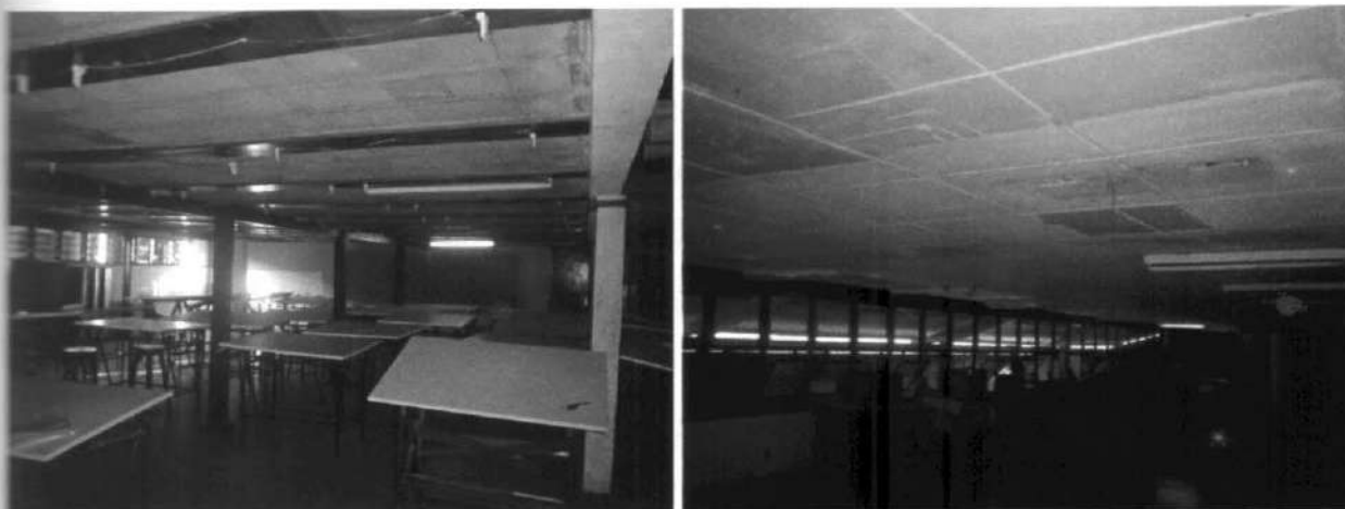
Figura 42 – Vista interna inferior e superior do Pavilhão Martins Filho do DAU. Fonte: Foto do autor
