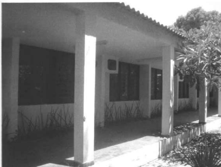
Figura 35 – Vista Externa do Biblioteca do DAU. Fonte: Foto do autor
