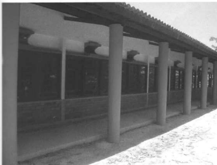
Figura 32 – Vista Externa do Bloco de Salas dos Professores do DAU. Fonte: Foto do autor
