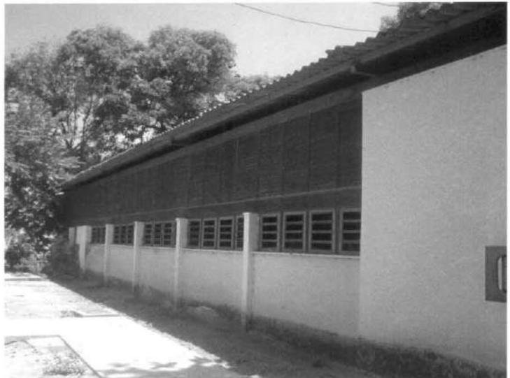
Figura 30 – Vista Lateral 1 do Pavilhão Martins Filho do DAU. Fonte: Foto do autor
