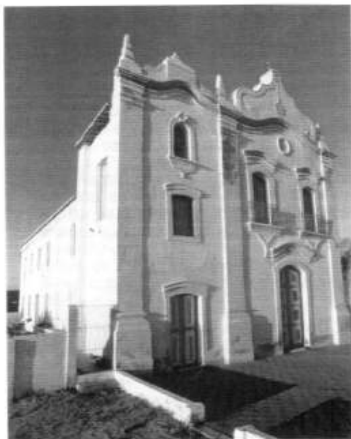
Figura 20 – Igreja de N. Sra. Da Conceição do Monte/Fotografia Mauricio Albano Fonte: Estudo para Tombamento Federal – ETF/Icó 1996
