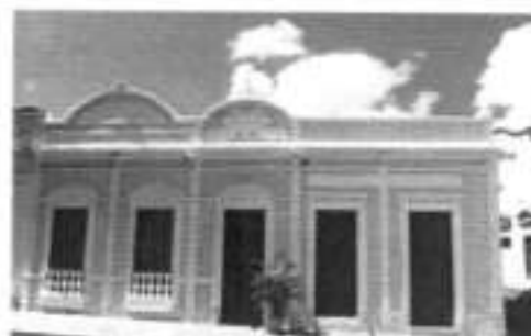
Foto 01 - Fachada da Rua Lamartine Nogueira.
