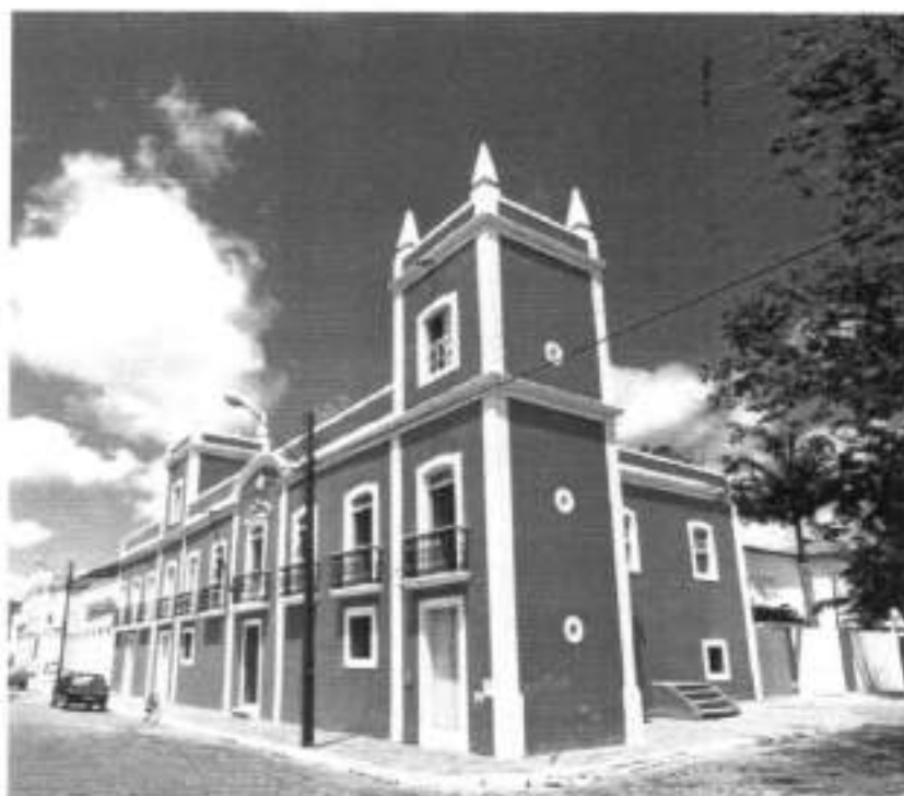
Figura 30 – Antiga Casa de Câmara e Cadeia (atual Câmara Municipal de Aracati) Fotografia Maurício Albano Fonte: Estudo para Tombamento Federal – ETF/Aracati 1998
