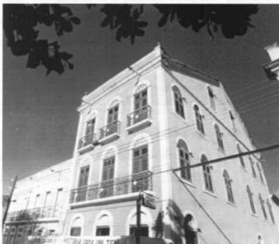
Figura 48 – Sobrado do Barão de Aracati (atual sede do Museu Jaguaribano) Fotografia Maurício Albano. Fonte: Estudo para Tombamento Federal – ETF/Aracati 1998
