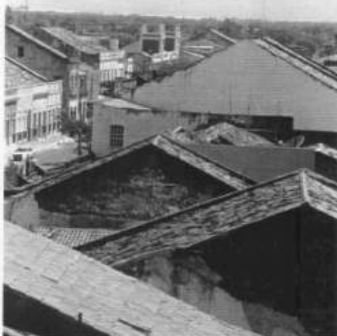
Figura 45 – Telhados dos sobrados do sítio histórico de Aracati Fotografia Maurício Albano Fonte: Estudo para Tombamento Federal – ETF/Aracati 1998
