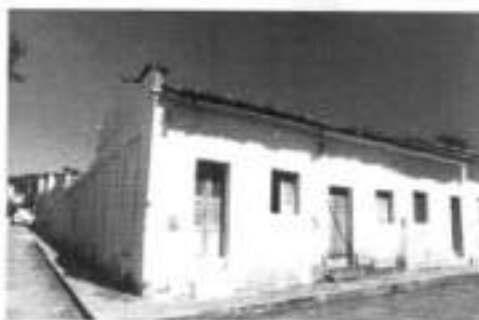
Foto 03 - Fachada da Rua Silva Jardim.
