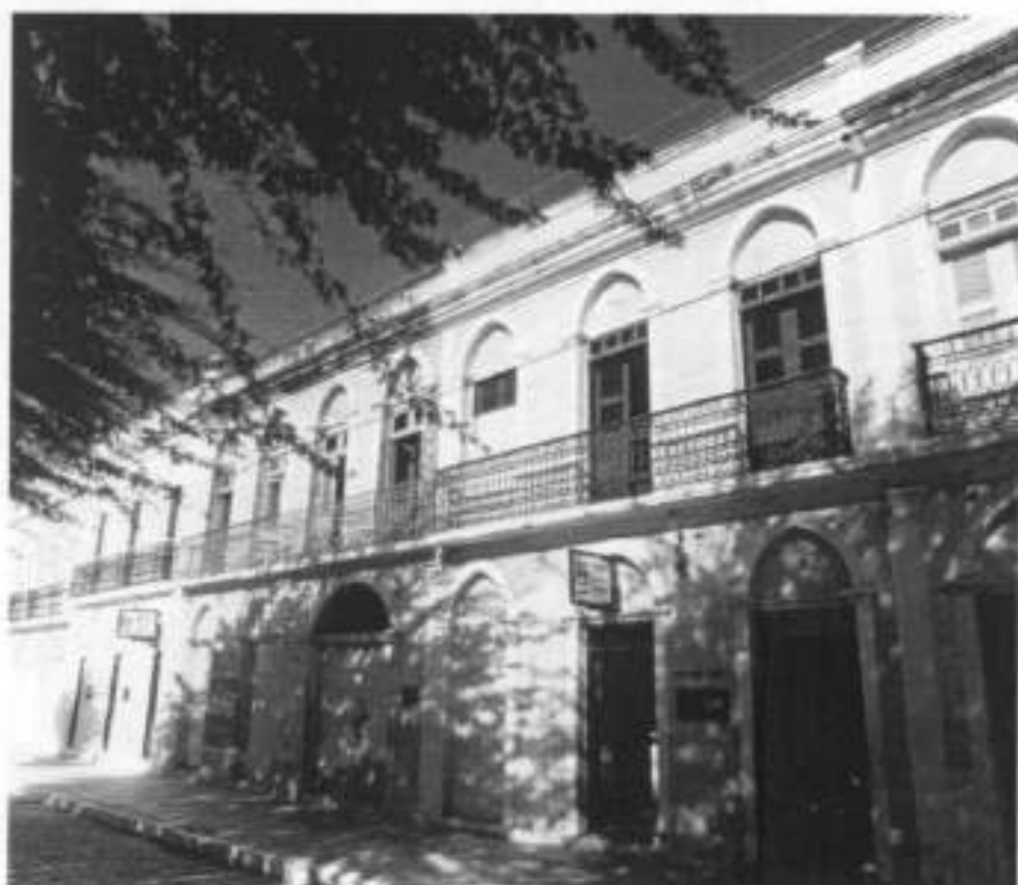
Figura 46 – trecho da Rua Cel. Alexandino/ Fotografia Maurício Albano Fonte: Estudo para Tombamento Federal – ETF/Aracati 1998
