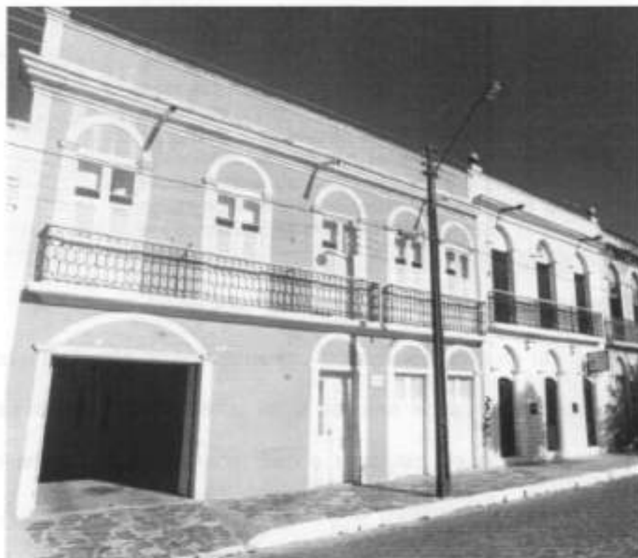
Figura 50 – Sobrados à Rua Cel. Alexanzito/ Fotografia Maurício Albano Fonte: Estudo para Tombamento Federal – ETF/Aracati 1998
