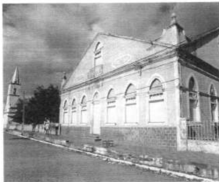
Figura 07 – Solar dos Antero/ Fotografia Maurício Albano Fonte: Estudo para Tombamento Federal – ETF/Icó 1996
