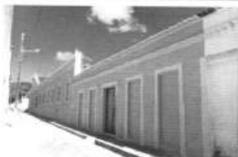
Foto 02 - Fachada da Rua Antônio Honório Passos.
