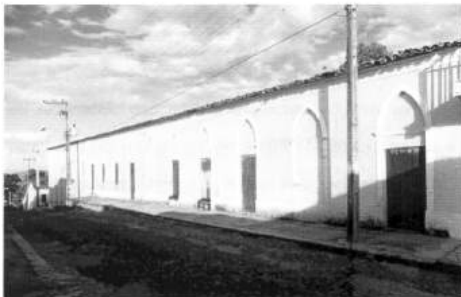
Figura 62 – Imóvel sito à Rua Fontenele Sobrinho/ Fotografia Jacques Antunes Fonte: Estudo para Tombamento Federal – ETF/Viçosa do Ceará 2002
