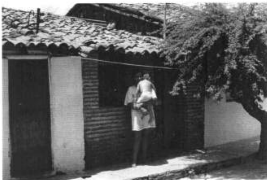
Figura 132 – Residências precárias situadas na margem esquerda do Rio Acaraú/ Fotografia Gentil Barreira Fonte: Estudo para Tombamento Federal – ETF/Sobral 1997
