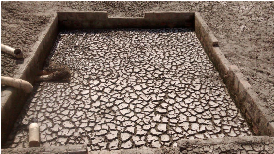
Figura 4- Caixa de coleta localizada no fundo dos viveiros, utilizadas na drenagem.
