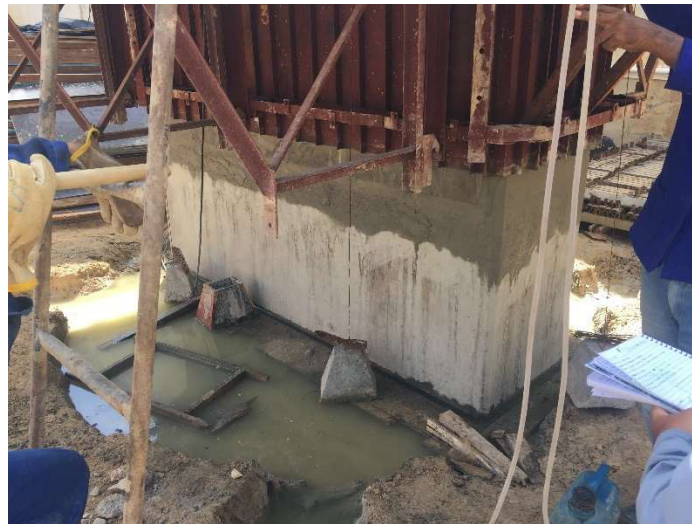
Figura 21 – Base de pilar executado com forma deslizante
