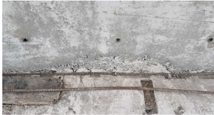
Figura 20 – Ninho de pedra em pilar alto executado pelo método convencional
