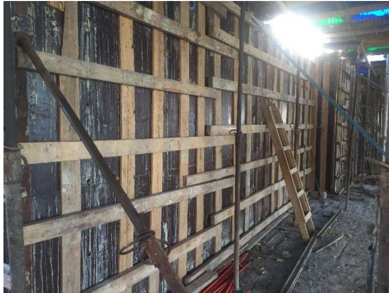
Figura 4 – Forma de pilar com compensados estruturados
