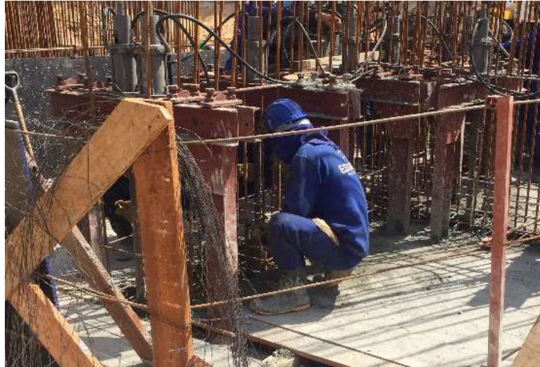
Figura 14 – Ferreiros posicionando a armadura transversal
