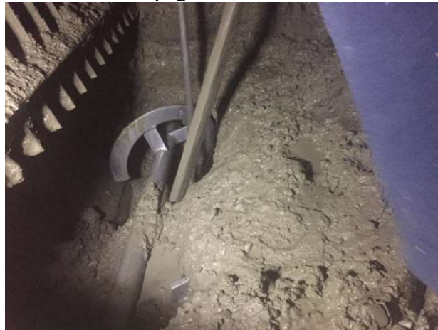
Figura 22 – Concreto iniciando pega na bomba com duas horas após misturado
