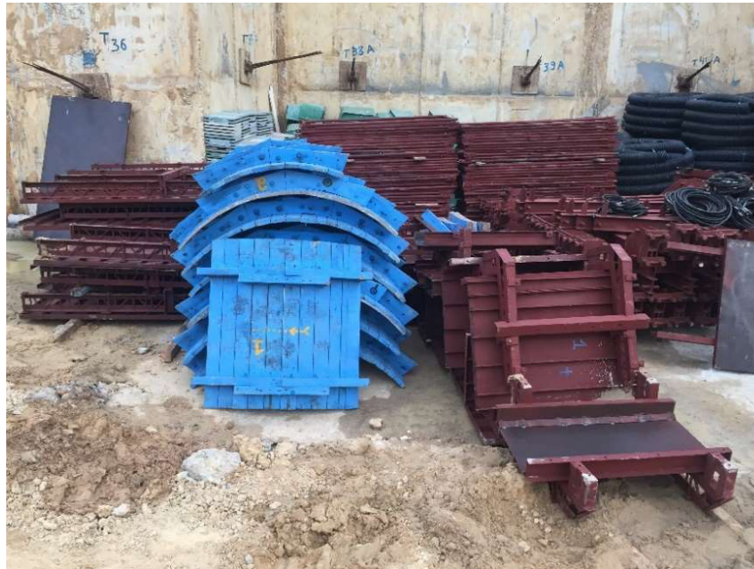
Figura 6 – Peças das fôrmas desmontadas
