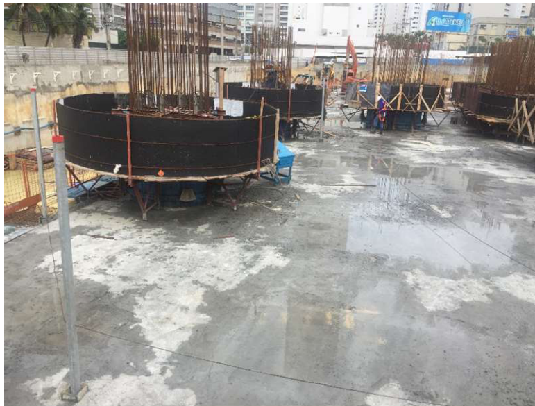
Figura 16 – Fôrmas deslizantes posicionadas um dia após a concretagem da laje anterior
