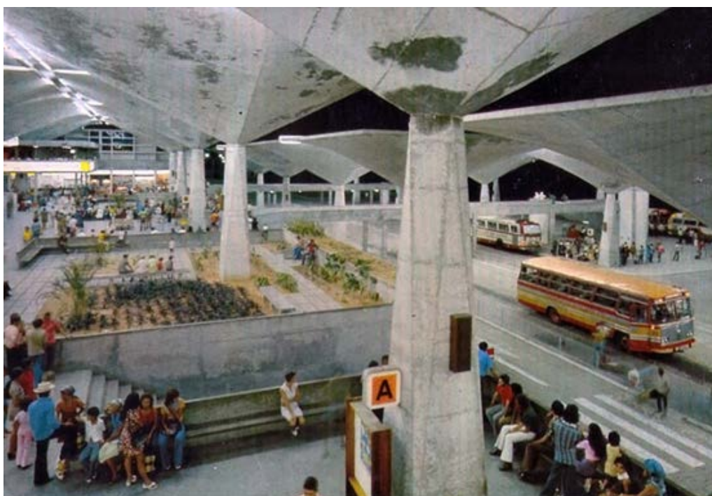
FIGURA51. Espaço interno da Rodoviária de Fortaleza, nos anos de 1980. À esquerda, área pública do terminal. À direita, área das plataformas de embarque e desembarque. Fonte: http://www.fortalezanobre.com.br/search/label/Rodovi%C3%A1ria%20Engenheiro%20Jo%C3%A3o%20Tom%C3%A9
