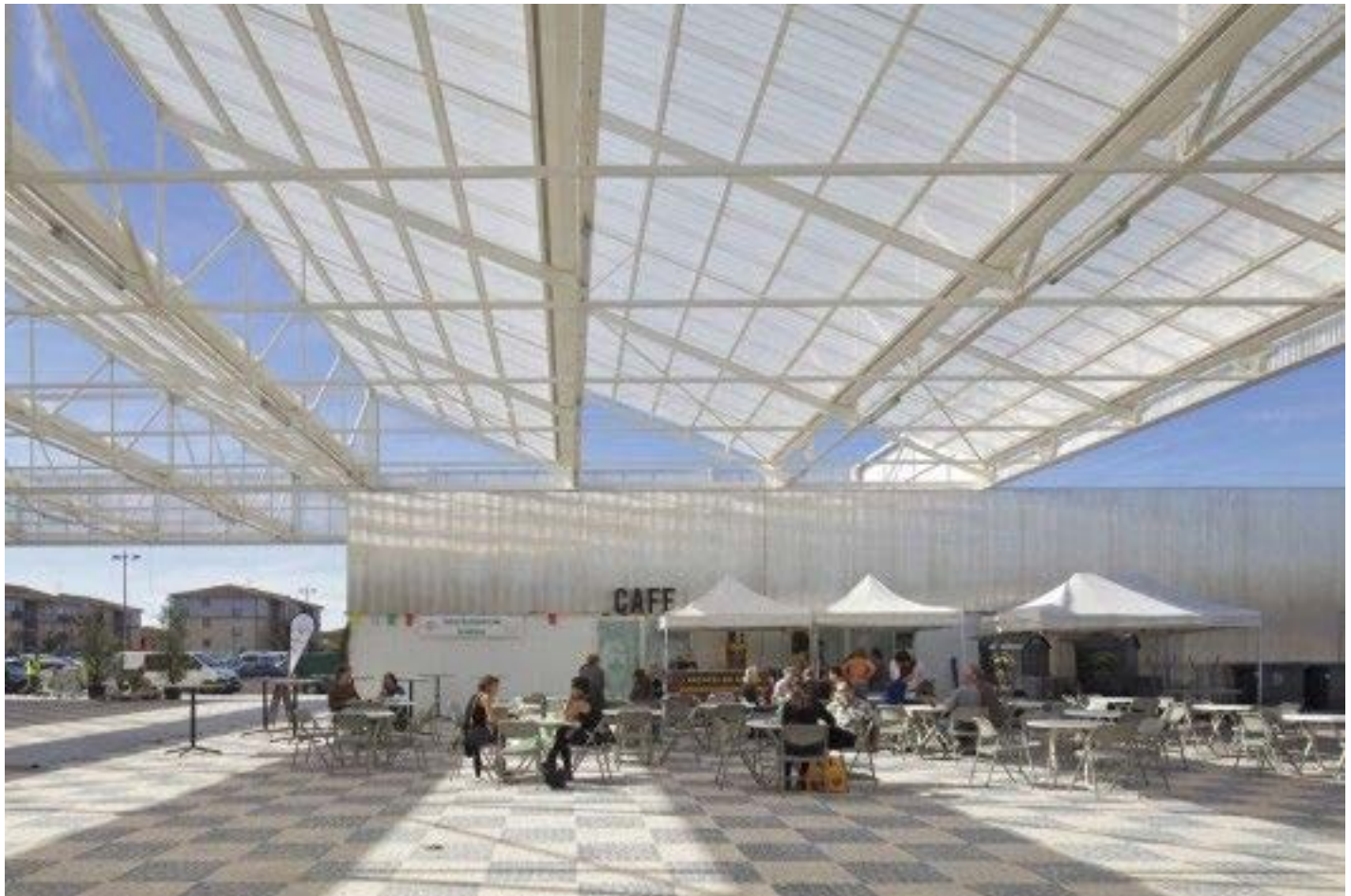
FIGURA66. Espaço interno, com destaque para a estrutura metálica da cobertura, que configura uma área de praça protegida das intempéries.
