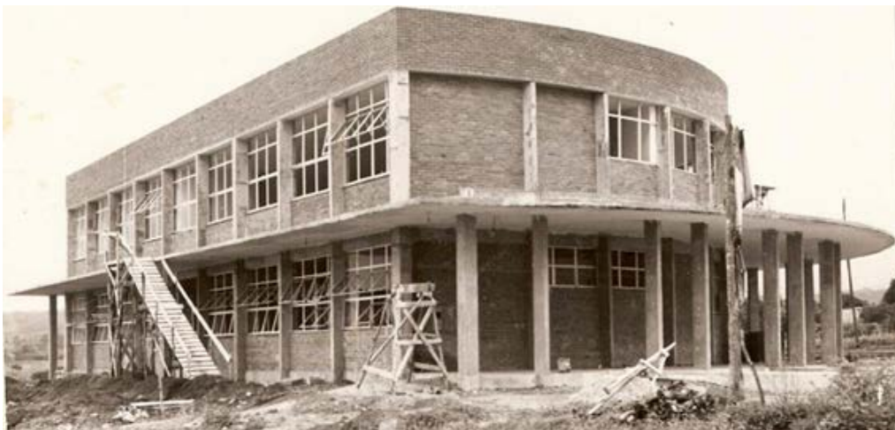
FIGURA41. Rodoviária de Crato no período de sua construção.
