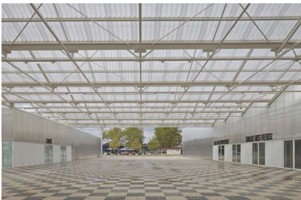
FIGURA64. Um dos acessos peatonais no edifício. Fonte: http://www.archdaily.com/488741/espace-monestie-ppa
