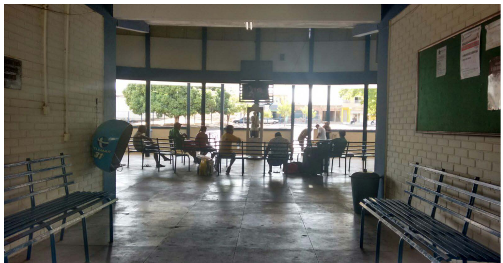
FIGURA44. Área de espera da atual Rodoviária de Crato.
