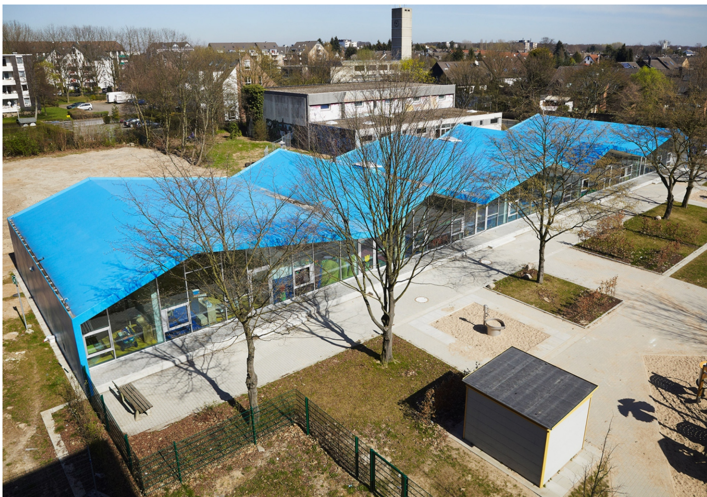
FIGURA 4.6: Vista aérea. Fonte: http://www.v-architekten.com/files/images/projekte/KIM/images/KIM_11_Kindergarten_Dachaufsicht.jpg
