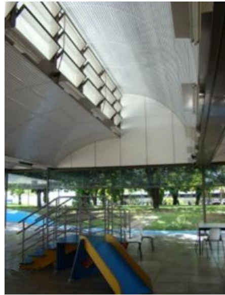
FIGURA 3.7: Área coberta. Fonte: VALVERDE, 2014.
