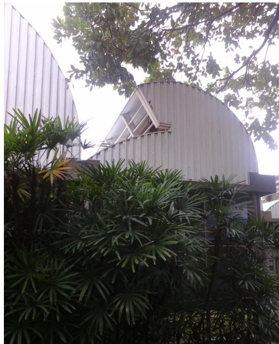
FIGURA 3.4: Coberta em shed com brises. Fonte: Foto da autora.
