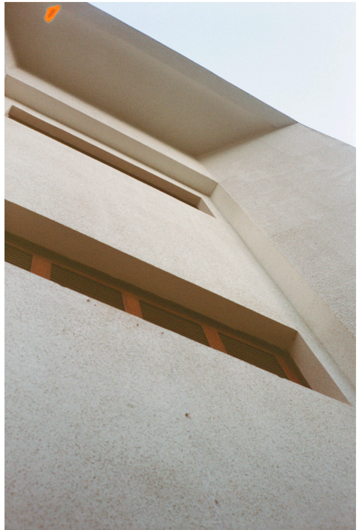
65. Detalhe das varandas e detalhe volumétrico. Conjunto Quéops, Quéfren e Miquerinos. Ana Pinho, Olympus Trip 35mm.
