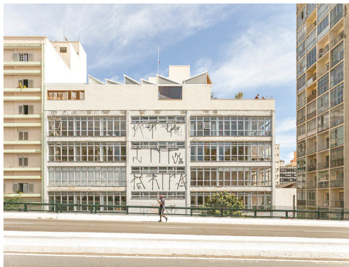
22. Vistas sob a perspectiva externa e interna da relação nova edificação x via elevada. Escritório Vapor.
