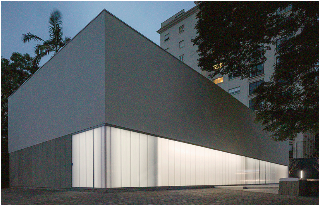
19. Galeria Casa Triângulo, Metro Arquitetura. Revista Projeto, 2016.
