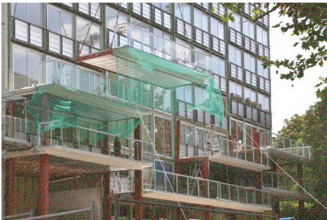
08. Fixação dos elementos pré-moldados. Vitruvius, 2010.
