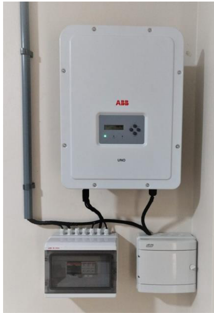
Figura 6 - Exemplo de instalação com inversor string
