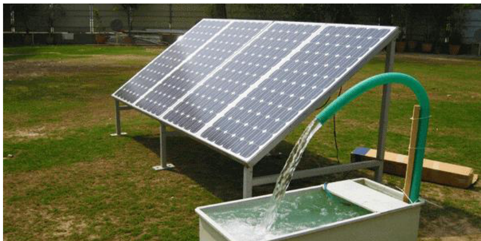
Figura 4 - Sistema off-grid autônomo de bombeamento solar
