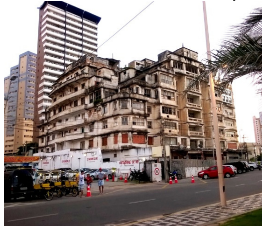
FIGURA 66 – Edifício São Pedro hoje.
