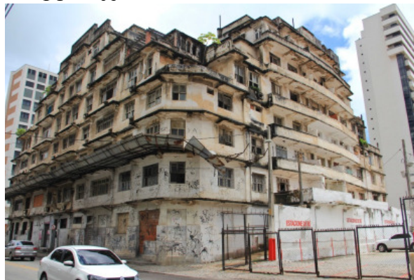
FIGURA 63 – Edifício São Pedro atualmente.
