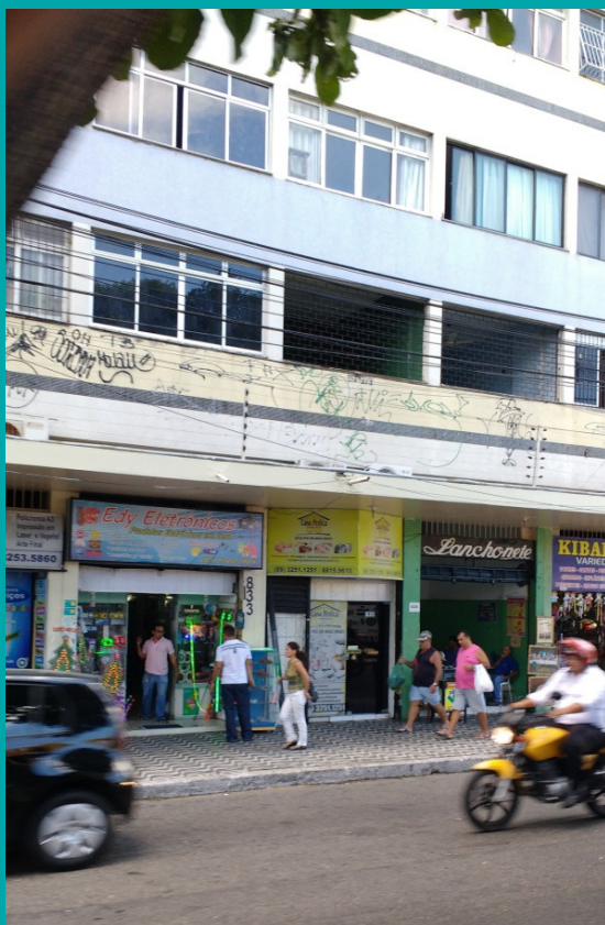
FIGURA 15 – Prédio misto localizado no Centro onde o térreo é ocupado por lojas variadas e os demais pavimentos são apartamentos.
