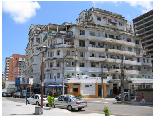
FIGURA 64 – Edifício São Pedro atualmente.
