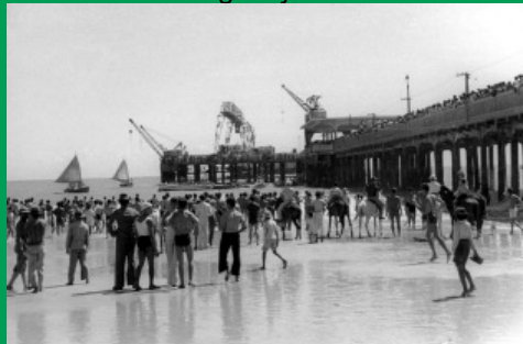
FIGURA 35 – Inauguração da Ponte Metálica
