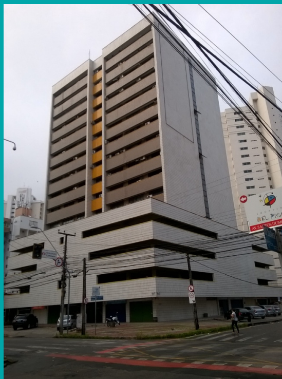
FIGURA 14 – Edifício comercial localizado na Aldeota. No térreo existem lojas e conveniências; nos primeiros andares estacionamento e salas comerciais na torre.
