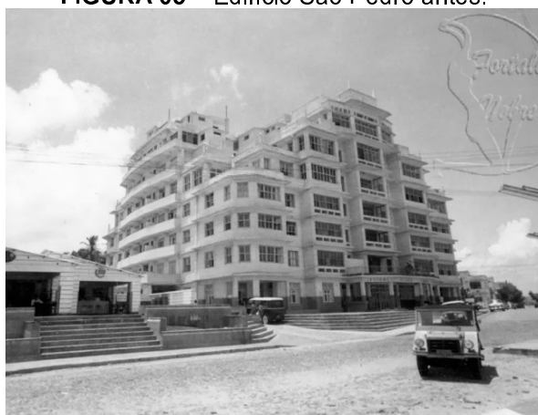
FIGURA 65 – Edifício São Pedro antes.
