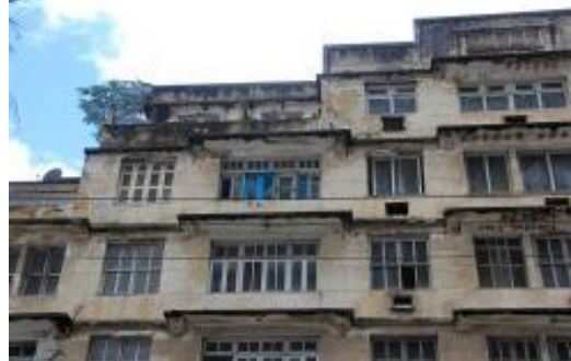
FIGURA 80 – Térreo isolado por alvenaria.
