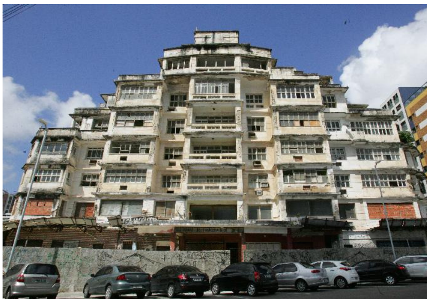
FIGURA 62 – Edifício São Pedro atualmente.
