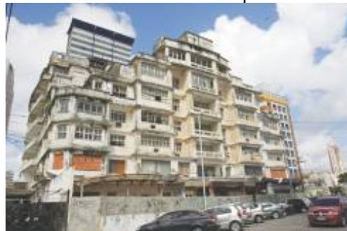
FIGURA 72 – Térreo isolado por alvenaria.
