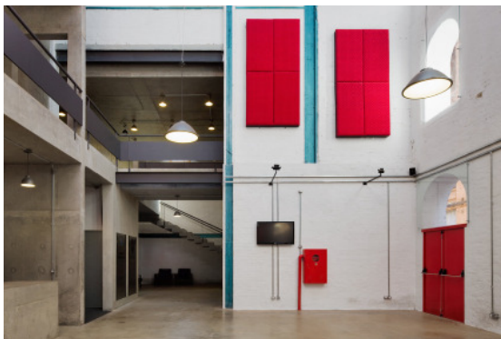
FIGURA 31 –Vista interna do prédio.
