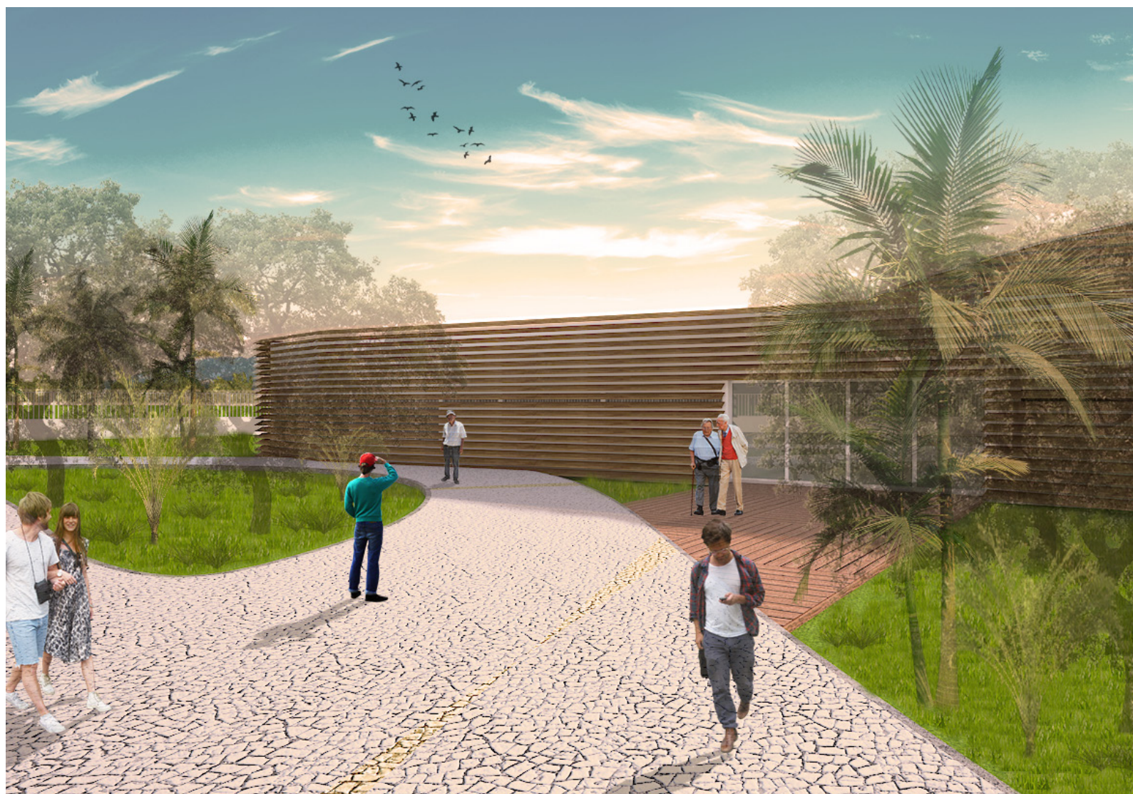
FIGURA 47 Perspectiva da fachada norte da Clínica de Saúde Integrada, mostrando a utilização dos brises em madeira. Fonte: desenvolvido pela autora, em conjunto com Gisela Parente.
