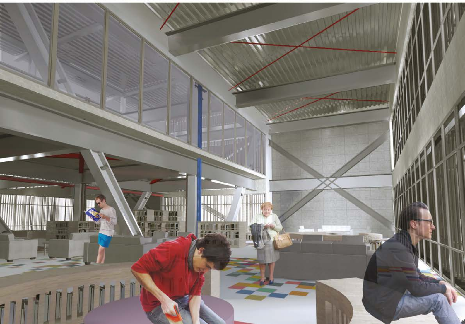
IMAGEM 8 - Contraventamento estrutural na lateral e no teto marcam os ambientes do edifício.
