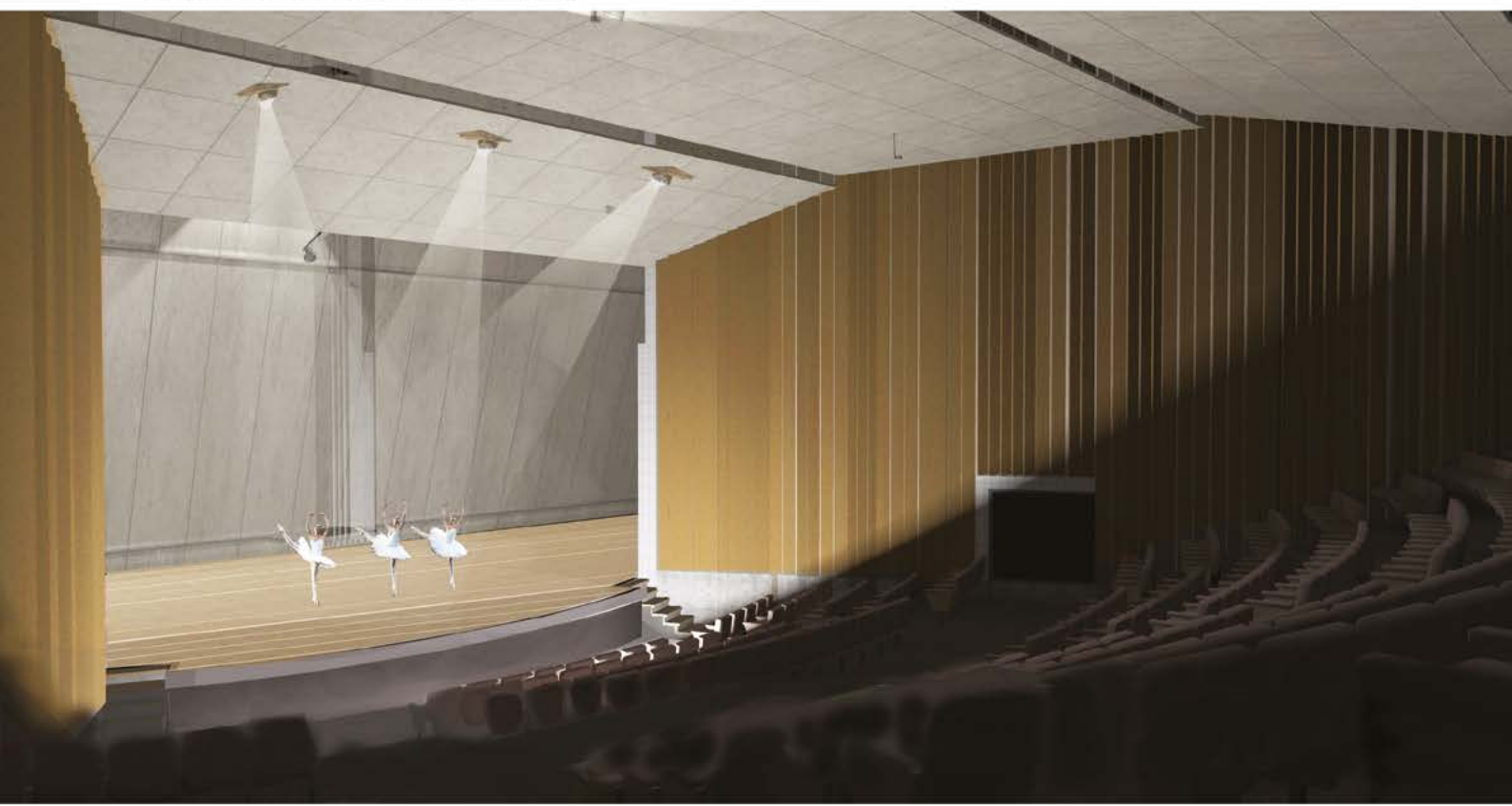
IMAGEM 16 - Vista da plateia para o palco. As placas acústicas no forro e nas paredes laterais garantem que o som se propague atingindo adequadamente todas as cadeiras.
