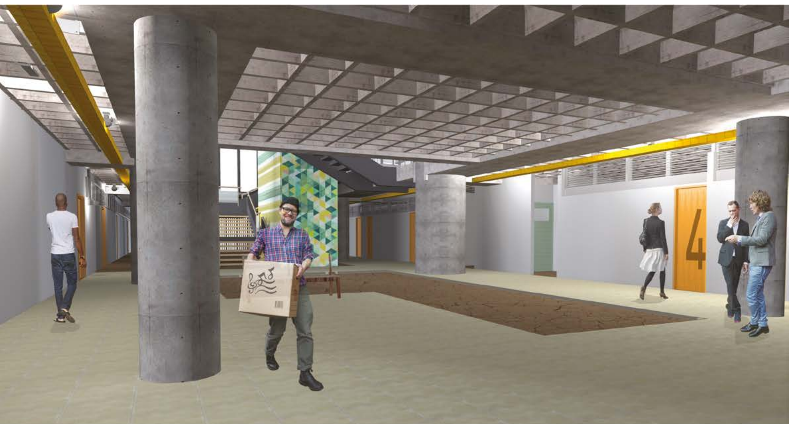
IMAGEM 15 - No pavimento subsolo, a estrutura é toda de concreto com lajes nervurada.
