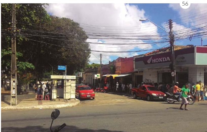
Fig 53 Estação da Parangaba rebaixada para se adequar o projeto METROFOR. Fig 54 Fundos da Igreja Bom Jesus dos Aflitos. Nota-se o mau uso da via que serve como estacionamento de veículos de carga. Fig 55 Igreja Bom Jesus dos Aflitos. Fig 56 Praça dos Caboclos (matriz). À esquerda a fila estendida do restaurante popular Fonte: autora
