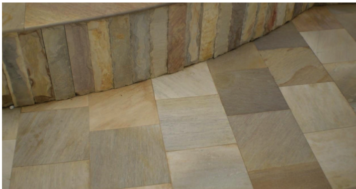
Fig. 5.18 - Piso em Pedra Cariri que será utilizado em todo o passeio de pedestre da via de acesso ao CIGA. Fonte: www.dldiferenciados.com
