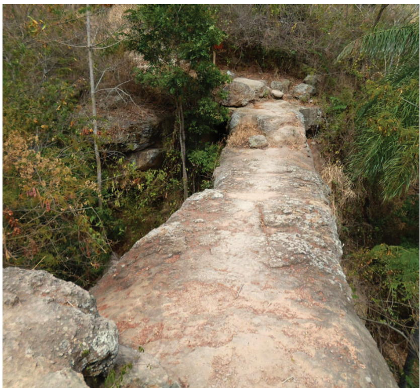
Fig. 2.34 - Atual forma da Ponte de Pedra Fonte: https://viajenachapada.files.wordpress.com/2014/01/geossc3adtio-ponte-de-pedra-nova-olinda-geopark-araripe-cearc3a1-3.jpg .
