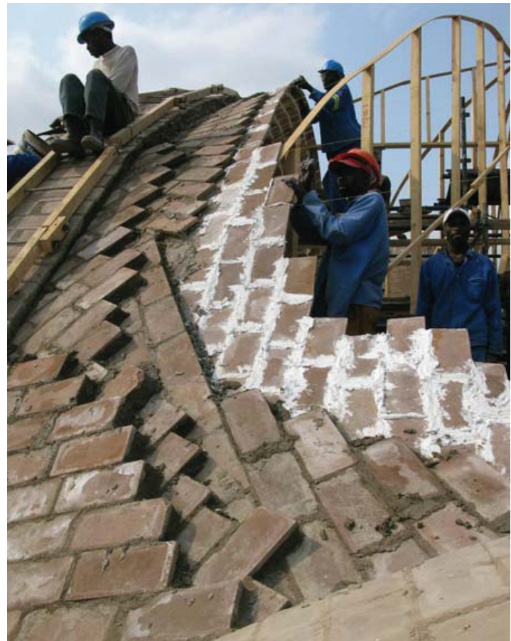
Fig. 4.07 - Sistema construtivo utilizando a mão-de-obra e os blocos cerâmicos locais Fonte: http://www.dezeen.com/2009/11/07/mapungubwe-interpretation-centre-by-peter-rich-architects/ .
