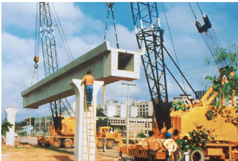
Figura 3 — Linha Piloto começa a ser construída Fonte: AEROMÓVEL BRASIL, 2011.
