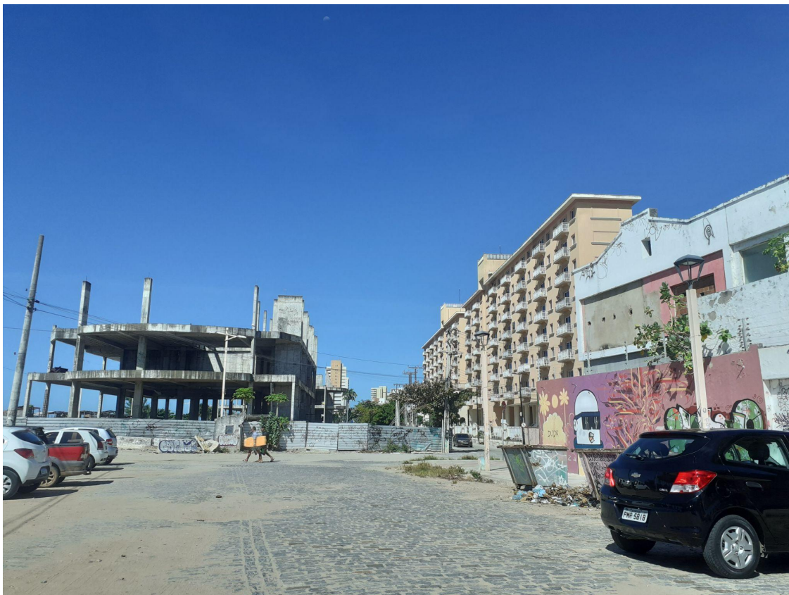
Figura 20: Obras inacabadas do Acquario Ceará
