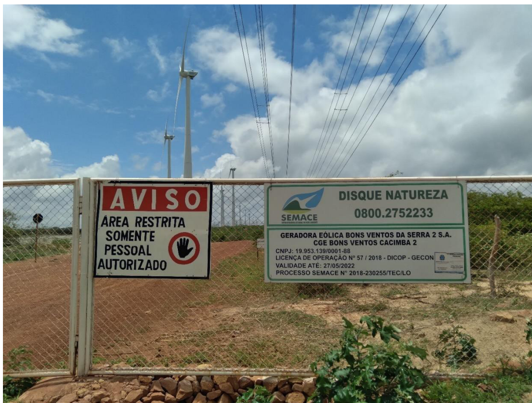
Figura 26 - Complexo Eólico Ventos de Tianguá e Bons Ventos da Serra 2 S.A.
