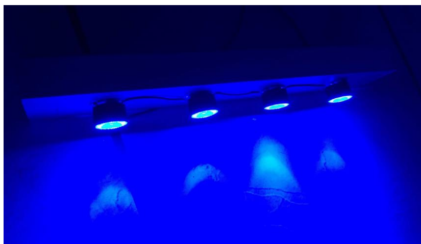
Figura 4 – LED's instalados na barra de alumínio e em funcionamento.
