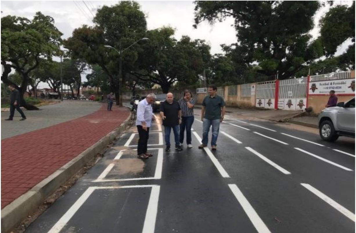
Figura 6. Obras de revitalização da Lagoa da Parangaba
