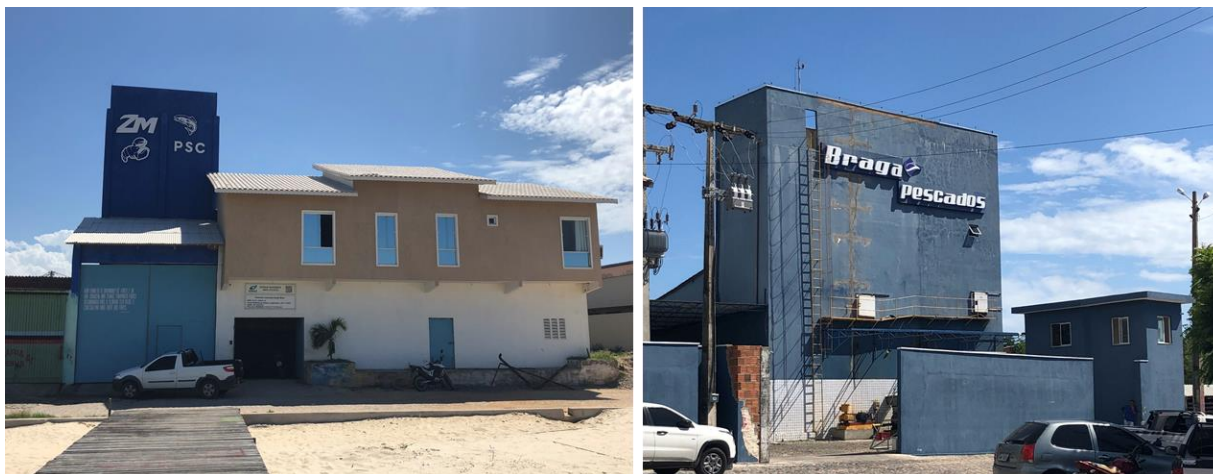
Figura 12 – Frigoríficos privados em Porto dos Barcos, Itarema.
