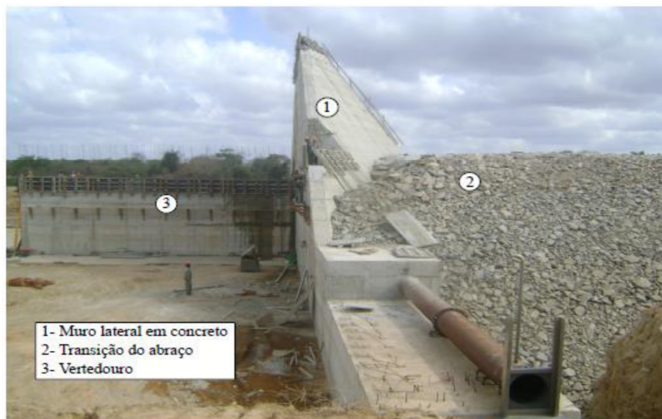
Figura 11 - Execução do abraço na barragem de Gameleira, em Ipipoca - CE
