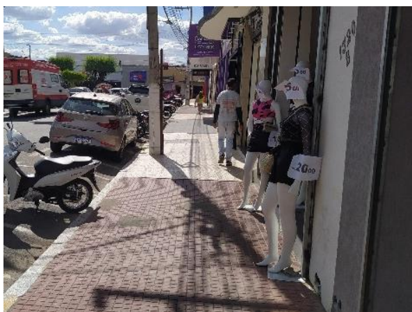
Figura 40 - Calçada com largura confortável
