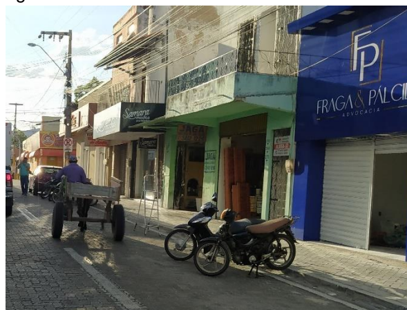
Figura 39 - Fachada com aberturas
