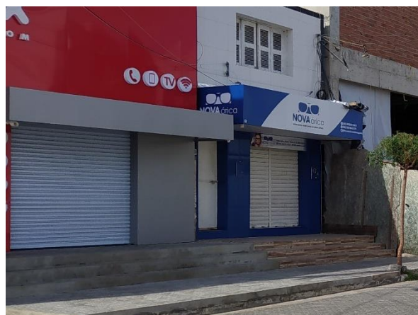
Figura 117 - Calçadas com desníveis 2
