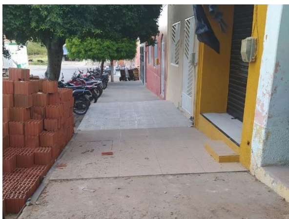
Figura 114 - Calçada com largura confortável
