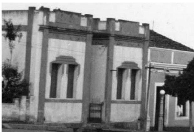
Figura 110 - Foto de edificação - antes
