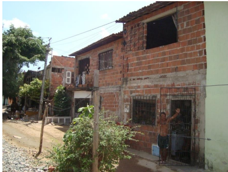
Figura 8 - Casas em construção ou reforma
