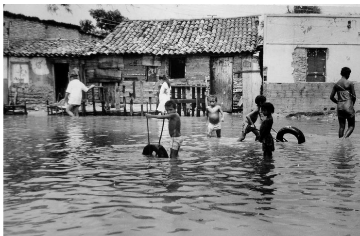
Figura 12 - Enchente no Lagamar
