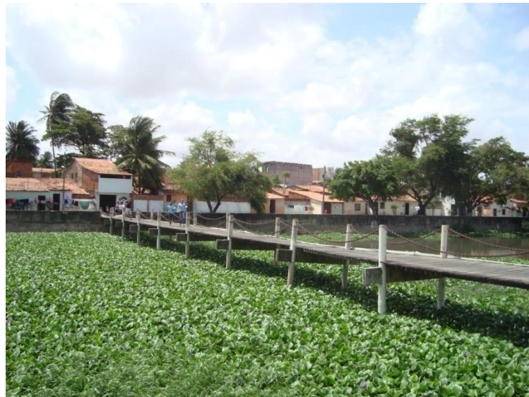
Figura 17 - Uma das pontes sobre o Canal
