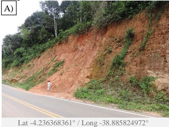
Figura 17 – Exemplos de movimentos de massa encontrados em Pacoti: A) Deslizamento Translacional recente na rodovia CE-253 (Latitude -4.236368361^{\circ} /Longitude -38.885824972^{\circ} ), B) Deslizamento Translacional antigo, já em fase de recuperação da vegetação, dentro do perímetro urbano da sede municipal, C) Deslizamento Translacional + Queda de Blocos em estrada secundária na zona rural, D) Deslizamento Translacional + Queda de Blocos na CE-065, próximo a sede municipal, E) Queda de Blocos na CE-065, provavelmente mais antigo, F) Queda de Blocos em estrada secundária da zona rural com blocos rochosos retangulares de \sim 2 m de comprimento, G) Bloco rochoso entre um bananeiral provavelmente participante de evento antigo de Queda ou Rolamento de Blocos e H) Poste de energia elétrica inclinado indicando movimento lento de Rastejo em zona rural
