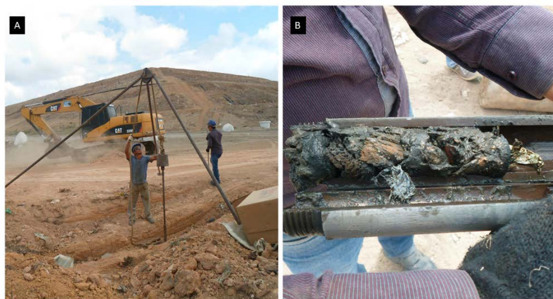
Figura 3 - Sondagens à percussão (SPT) a) Execução b) Coleta de amostra de RSU.
