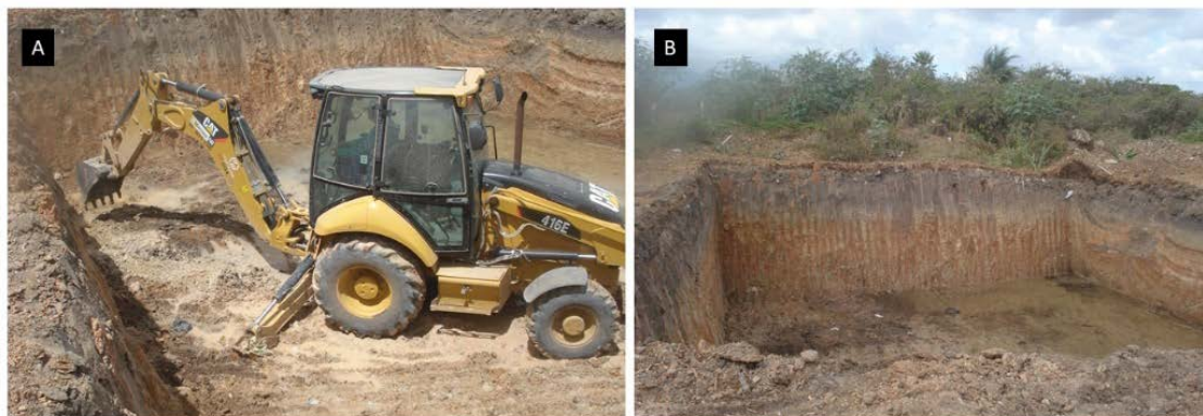
Figura 2 - Célula experimental a) Escavação utilizando uma retroescavadeira b) Escavação concluída.
