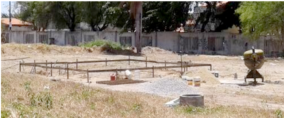
Figura 1. Vista del ambiente de hormigonado de pilotes.
