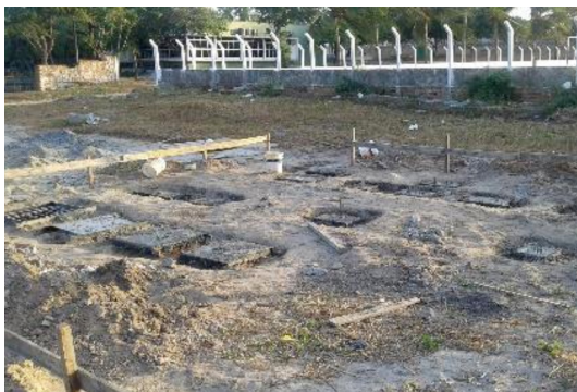
Figura 6. Vista de los grupos de pilotes de lo campo experimental de la UFC.
