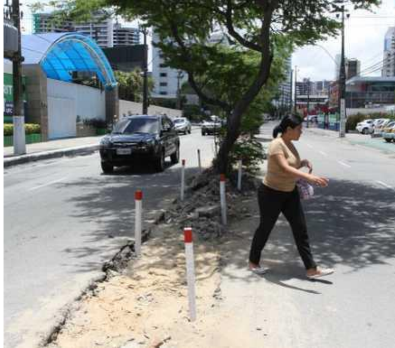
Figura 6: Avenida Dom Luís sem o canteiro central
