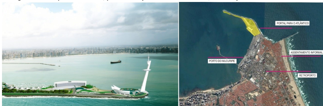
Figura 2. Portal para o Atlântico, parte do Projeto Fortaleza Atlântica, e a situação urbana real do entorno.
