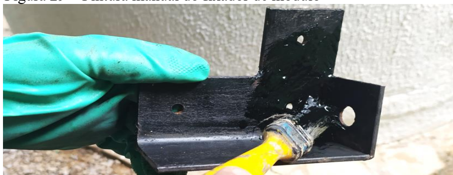
Figura 29 – Pintura manual do fixador de módulo
