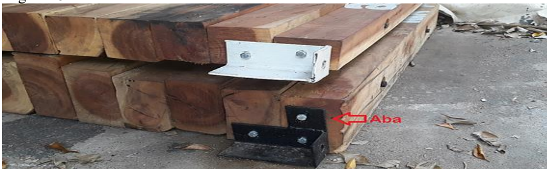
Figura 25 - Fixadores de módulos
