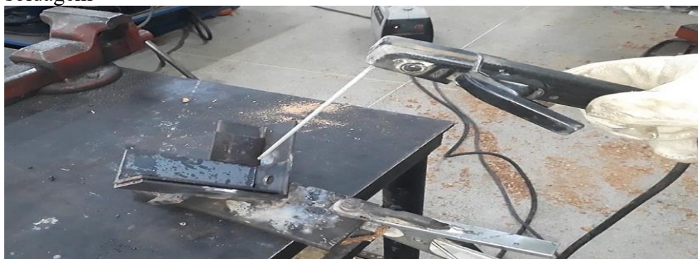
Figura 27 - Peças dos fixadores de módulos posicionadas no gabarito para soldagem
