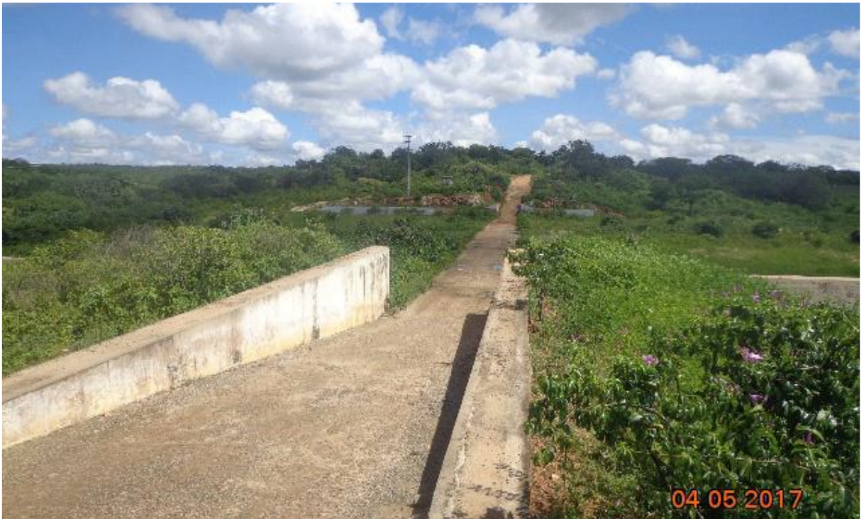
Figura 25 – Aspecto do vertedouro do açude Marengo – Madalena, CE.
