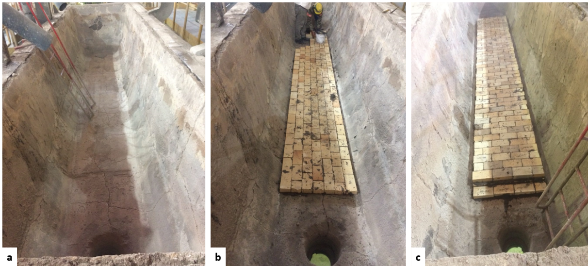
Figura 67 – Construção da sola elevada do distribuidor
