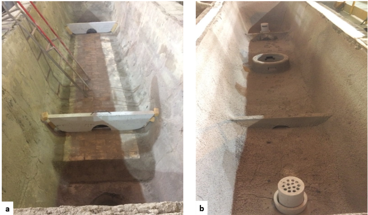
Figura 68 – Aspecto do distribuidor após a montagem da elevação da sola
