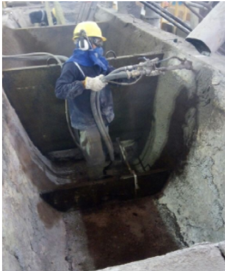
Figura 63 – Projeção de massa de cobertura ou concreto de trabalho no distribuidor
