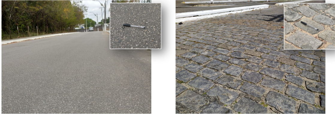
(a) Revestimento asfáltico.
