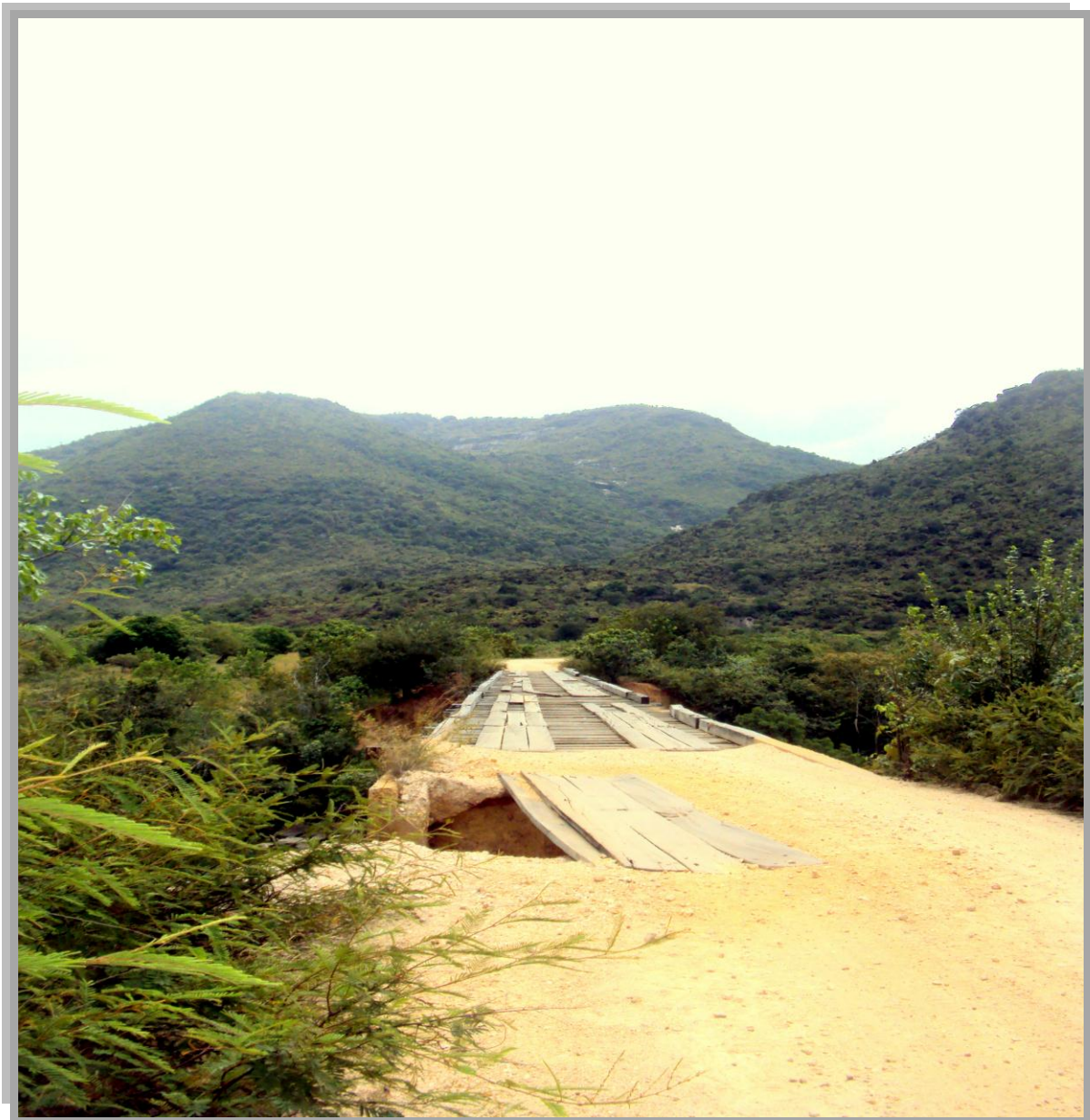
Figura 7 – Ponte sobre o Igarapé Urucuri na entrada da região das Serras na TIRSS
