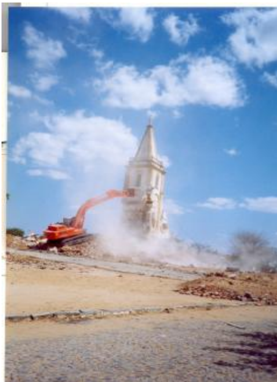
Fotografia 7: Igreja Matriz sendo destruída.
