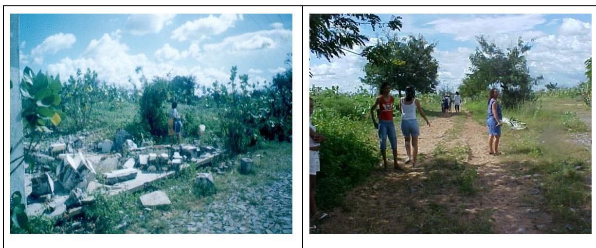
Fotografias 8 e 9: Ruas de Jaguaribara após a demolição.
