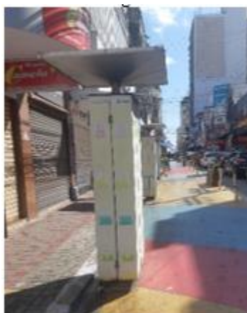
Figura 37 - Quiosque - Cobertura original
