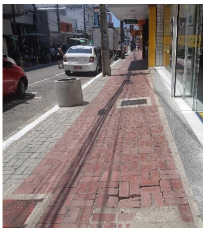
Figura 49 – Calçada, faixa de serviço e passeio
