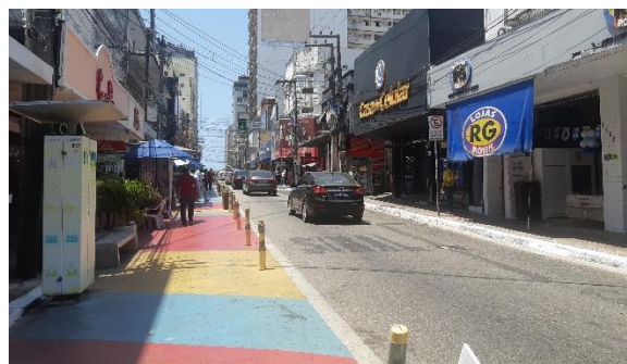
Figura 46 - Rua Barão do Rio Branco executada
