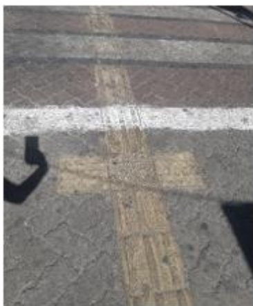
Figura 41 - Travessia Elevada na rua Liberato Barroso
