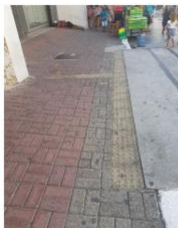
Figura 42 - Travessia Elevada na Tv. Severiano Ribeiro
