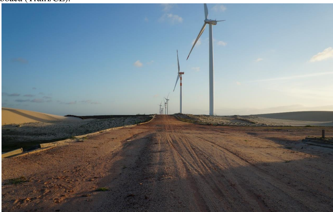
Figura 19 – Via de acesso aos aerogeradores construídas em meio ao campo de dunas da Emboaca (Trairi/CE).
