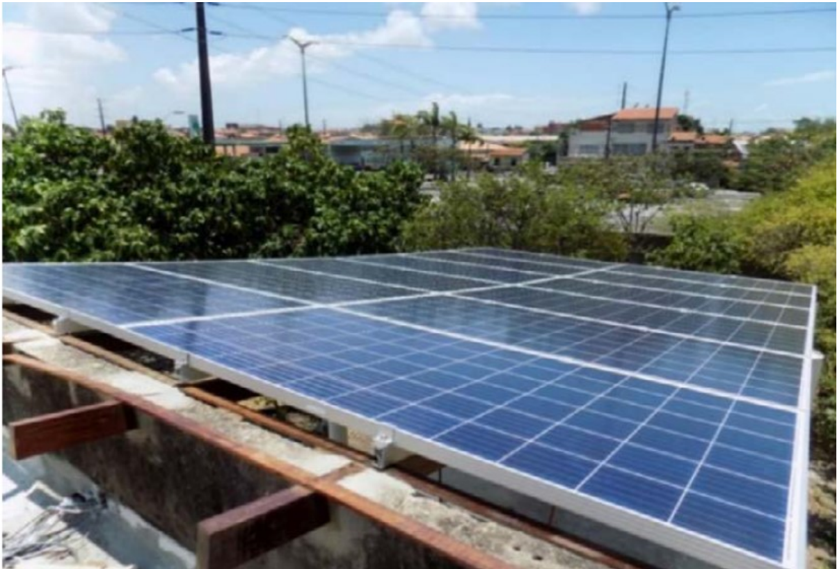
Figura 10 – Instalação da planta fotovoltaica no telhado do LEA-UFC.
