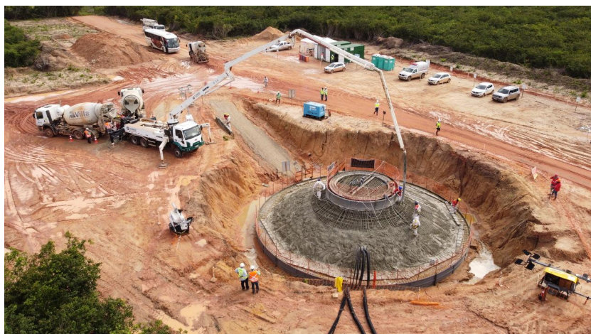
Figura 7 – Construção da fundação de parque eólico em Trairi.
