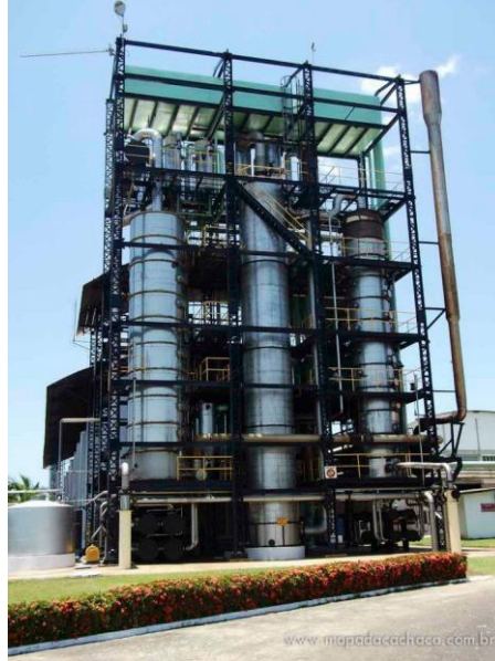
Figura 1 - Colunas de destilação de aço inox
