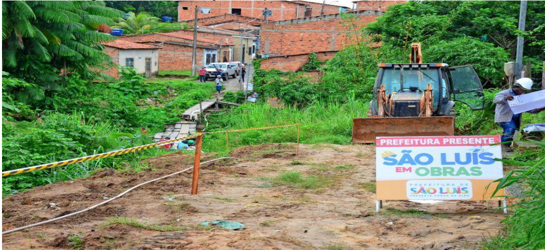
Figura 10- Construção de ponte sobre o Recanto Verde
