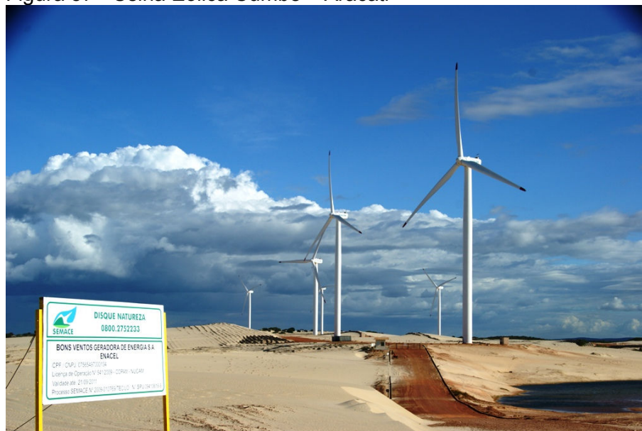
Figura 57 - Usina Eólica Cumbe – Aracati
