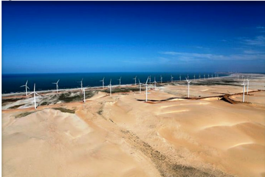
Figura 34 - Usina eólica Bons Ventos – Aracati
