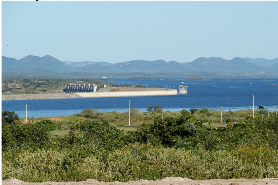
Figura 20 – Vista do Açude Castanhão com as comportas ao centro. Nova Jaguaribara
