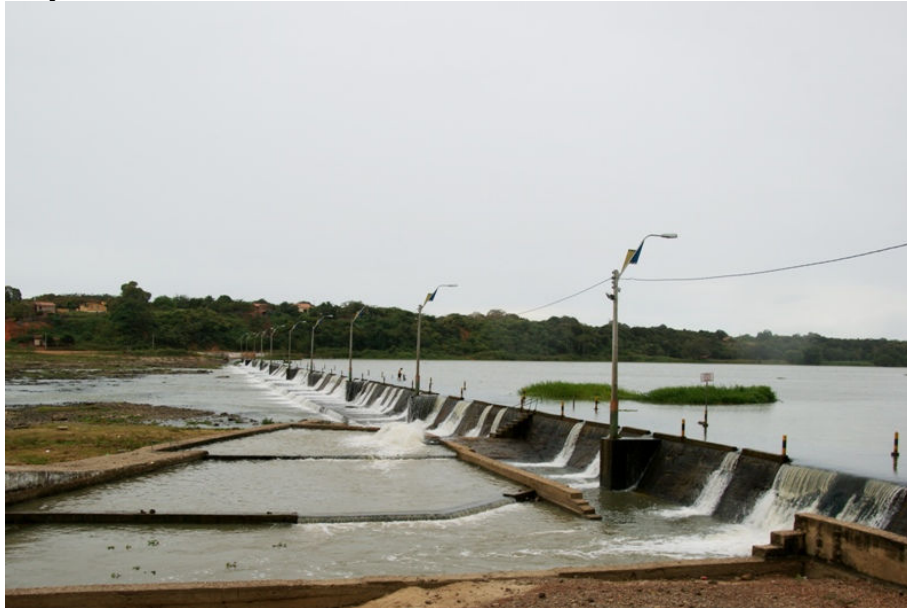
Figura 5- Passagem molhada e Início do Canal do Trabalhador – Itaíçaba - CE
