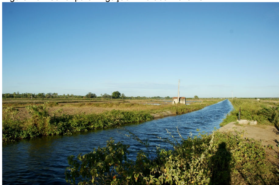
Figura 40 - Canal para irrigação - Morada Nova- CE.
