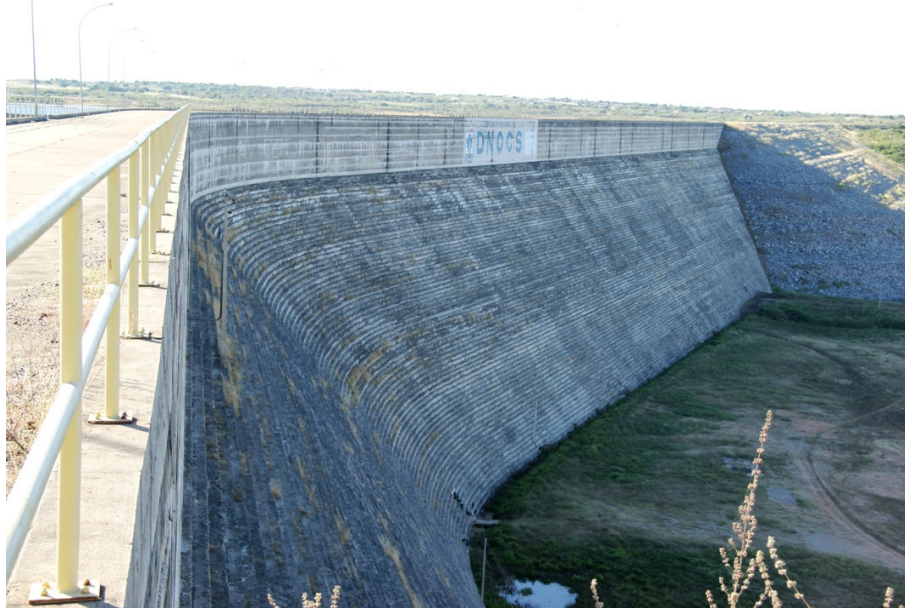
Figura 4- Parede do Açude Castanhão – Jaguaribara- CE.
