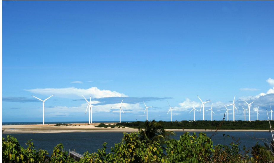
Figura 30 - Aerogeradores - Vista de Fortim- CE
