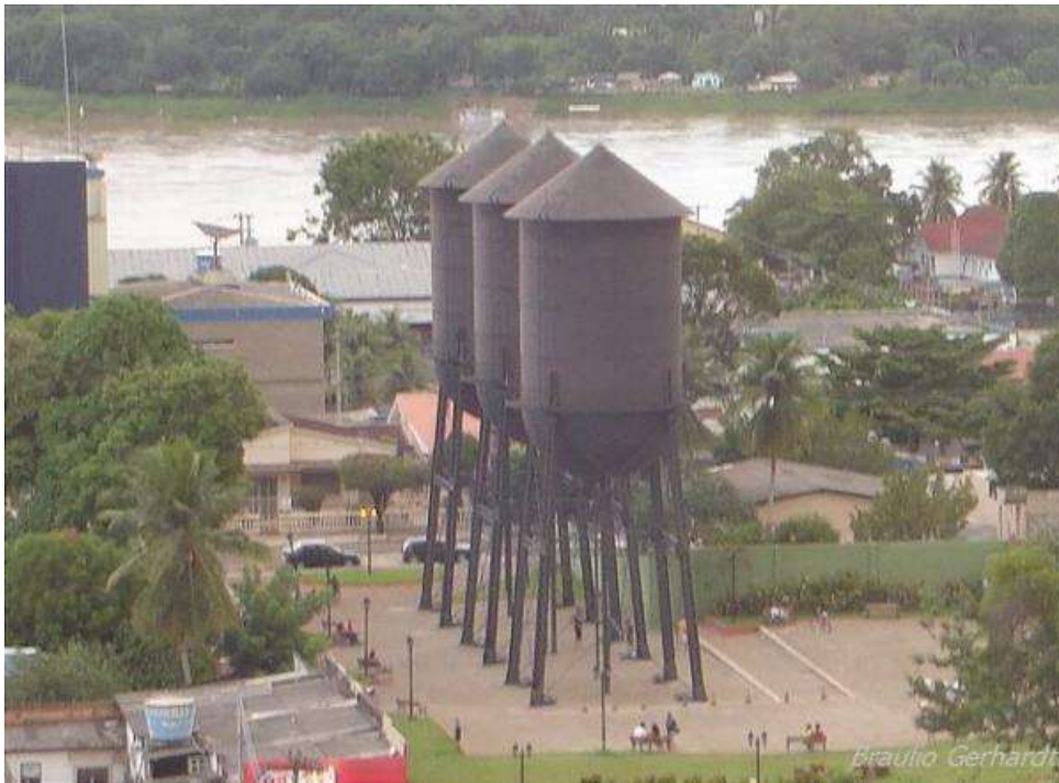
Figura 9 – Praça das Três Caixas D'água com vista para o Rio Madeira ao fundo.
