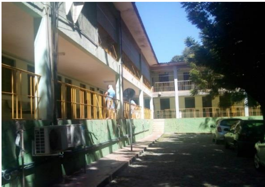
Figura 14 – Corredor III / Enfermaria III - Hospital da Messejana.
