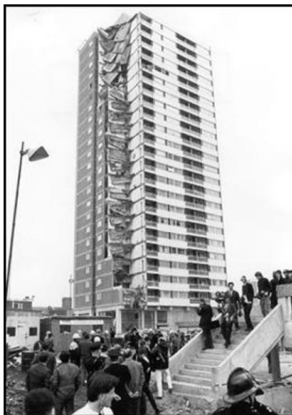
Figura 1 – Edifício Ronan Point após o colapso
