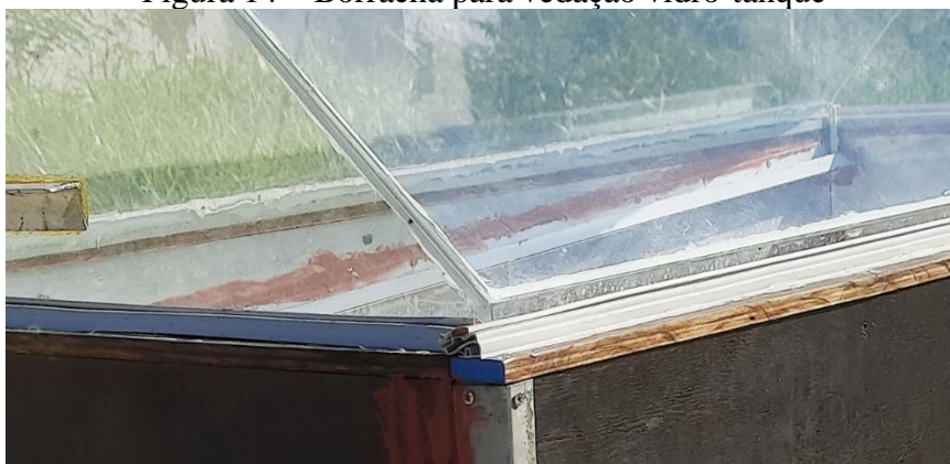
Figura 14 – Borracha para vedação vidro-tanque
