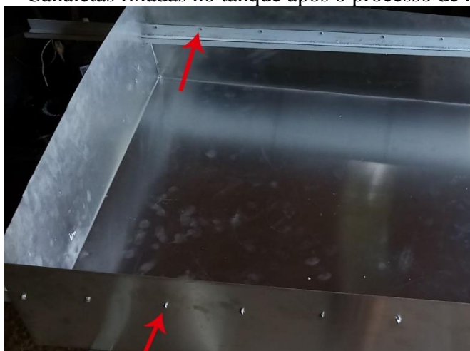
Figura 9 – Canaletas fixadas no tanque após o processo de rebiteagem
