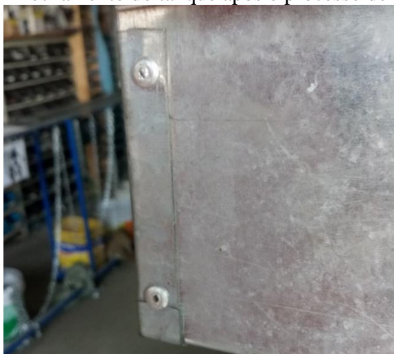
Figura 8 – Fechamento do tanque após o processo de rebiteagem
