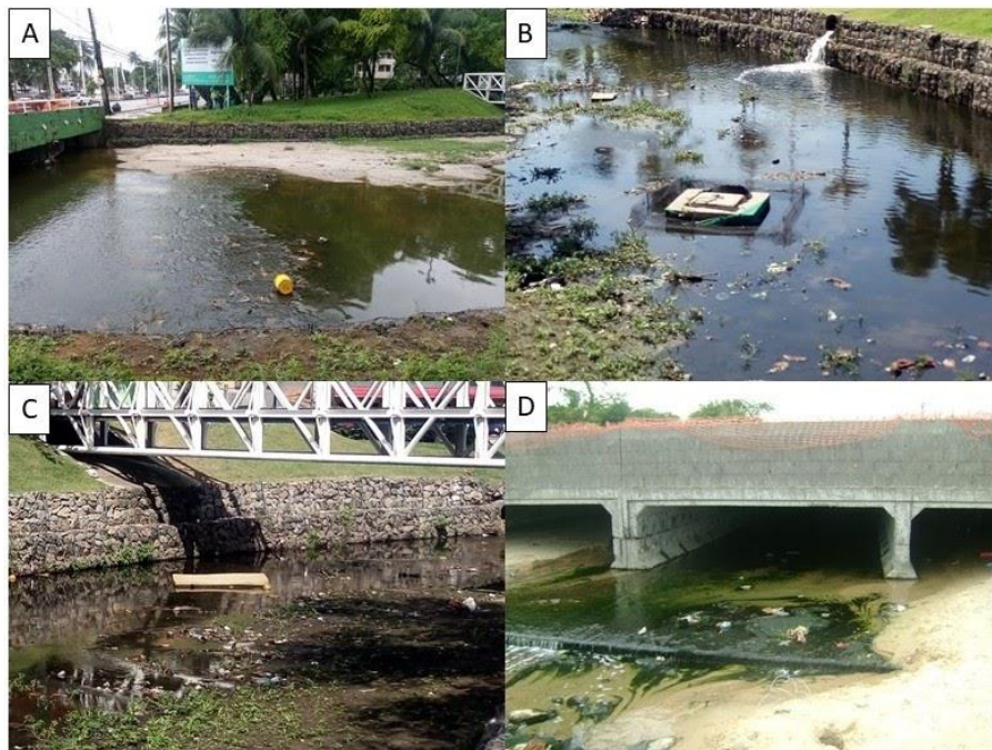
Figura 2: A - Assoreamento do leito; B - Presença de galeria dentro do leito; C - Disposição de resíduos; D - Foz do riacho Maceió.
