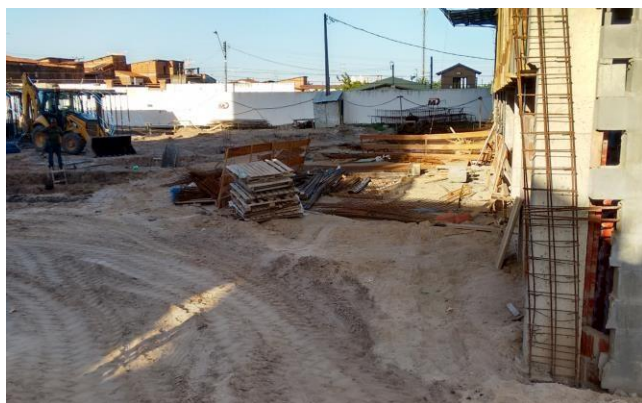
FIGURA 2 - Área de perigo (à esquerda na foto) sem demarcador vermelho.
