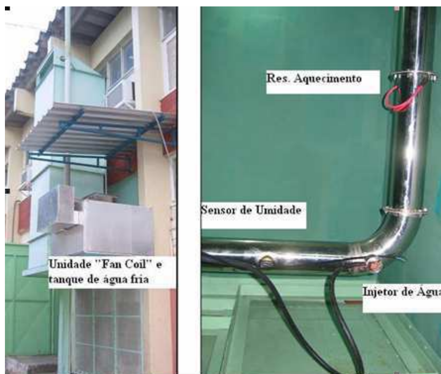
Figura 2: Componentes do sistema de condicionamento de ar e nova placa de interface.
