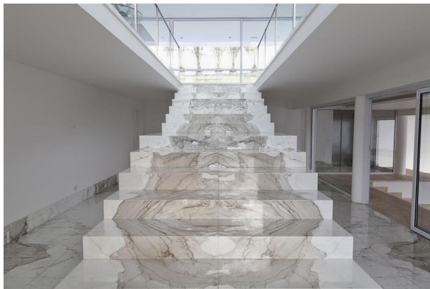
Figura 1 - Aplicação de rochas ornamentais como revestimento de uma escada em Mármore Calacata Gold.
