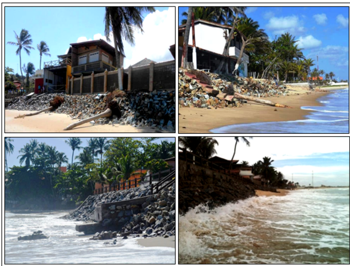
Figura 2 - Imagens dos impactos da erosão costeira na Praia da Taíba.
